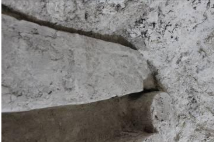
Figura 37. Cornisa sin raíces y después de consolidación de la superficie. (Foto: M. Colín, 2013).
