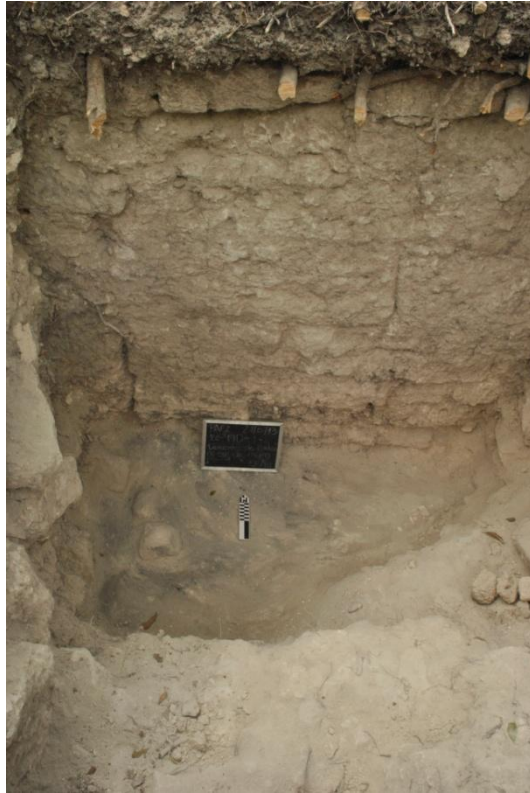
Figura 1.18. Muro Norte de la última etapa constructiva de Edificio F8-7. Se puede observar parte del depósito de ceniza en el relleno. Fotografía Edwin Román.
