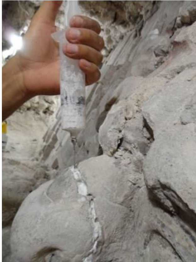
Figura 17. Inyección de lechada de cal en grieta de nariz. (Foto: E. Pérez, 2013).
