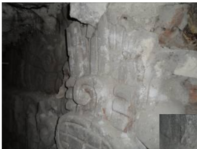
Figura 7. Manchas blancas de cal producto de intervenciones anteriores. (Foto: E. Pérez, 2013).
