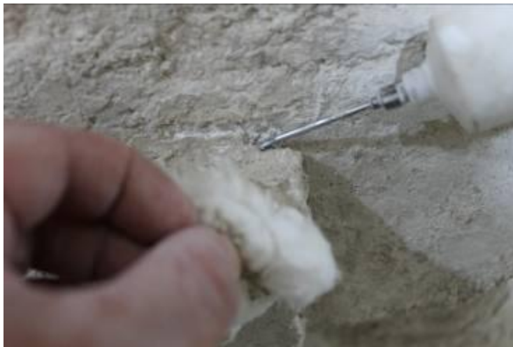
Figura 38. Inyección de lechada de cal en una grieta para fijar desprendimiento. (Foto: M. Colín, 2013).
