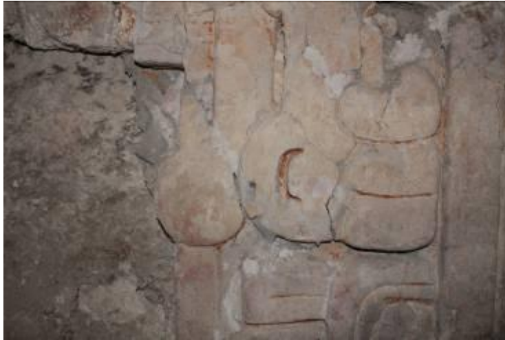
Figura 25. Aplicación de vendolites en grietas, simultáneamente a la excavación. (Foto: M. Colín, 2013).
