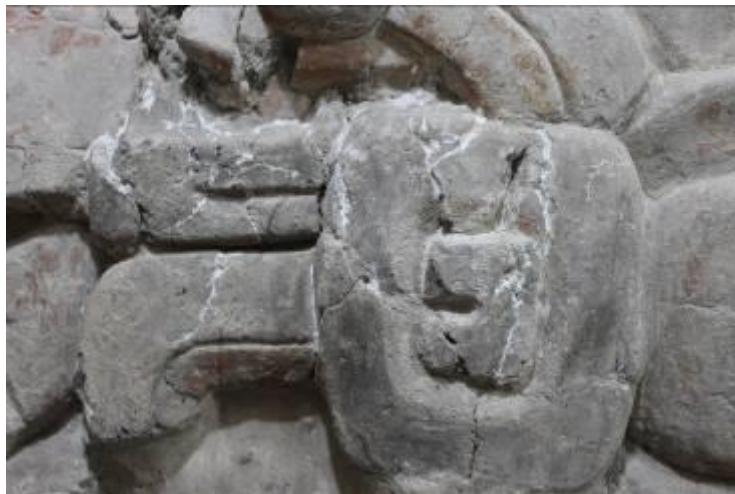
Figura 18. Inyección de lechada de cal en grietas. (Foto: M. Colín, 2013).
