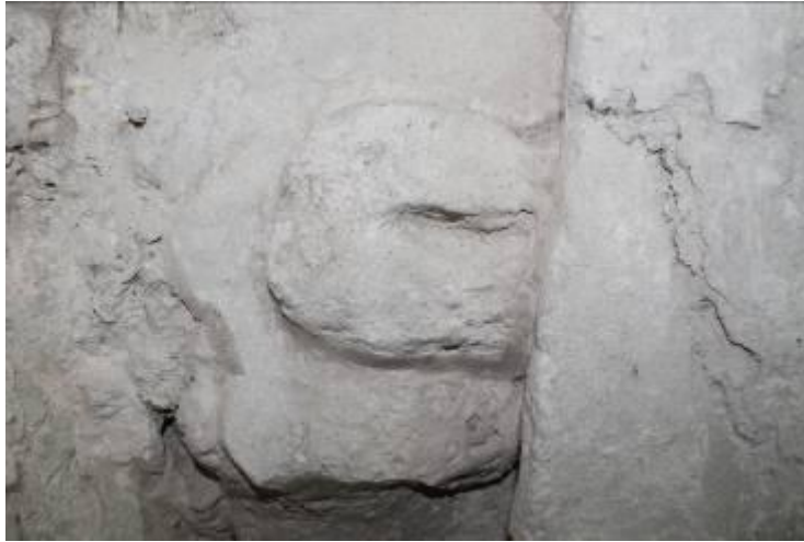
Figura 47. Elemento decorativo después de ser adherido en su sitio original. (Foto: M. Colín, 2013).
