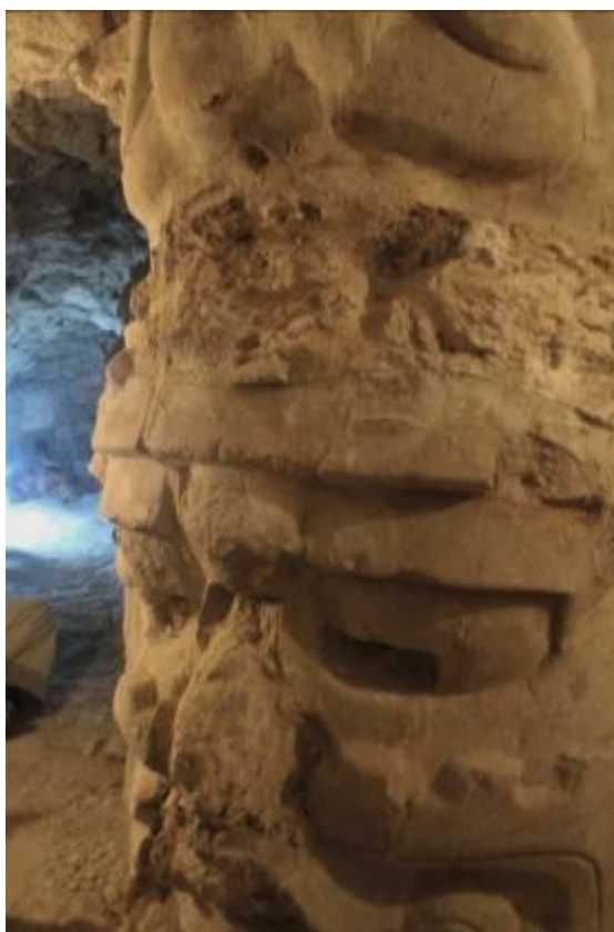
Figura 11. Mascaron con tocado y nariz parcialmente destruidos. (Foto: M. Colín, 2013).
