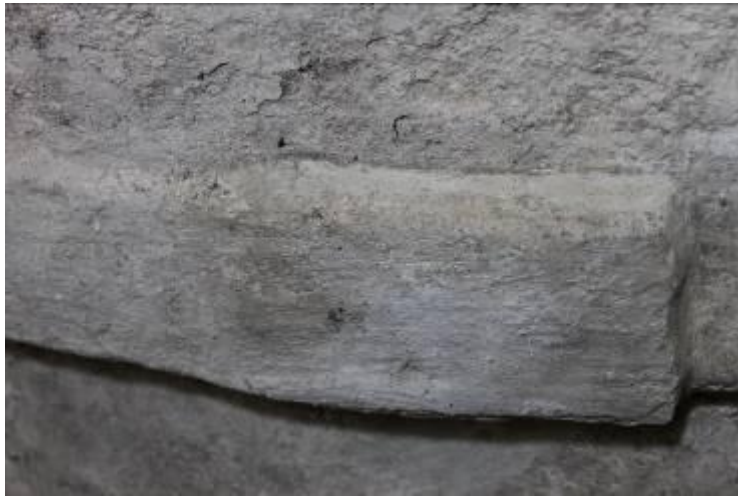
Figura 42. Elemento decorativo después de consolidación y resane. (Foto: M. Colín, 2013).
