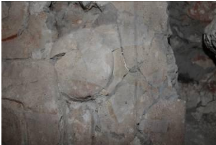
Figura 26. Vendolites aplicados en zonas propensas a desprenderse. (Foto: M. Colín, 2013).
