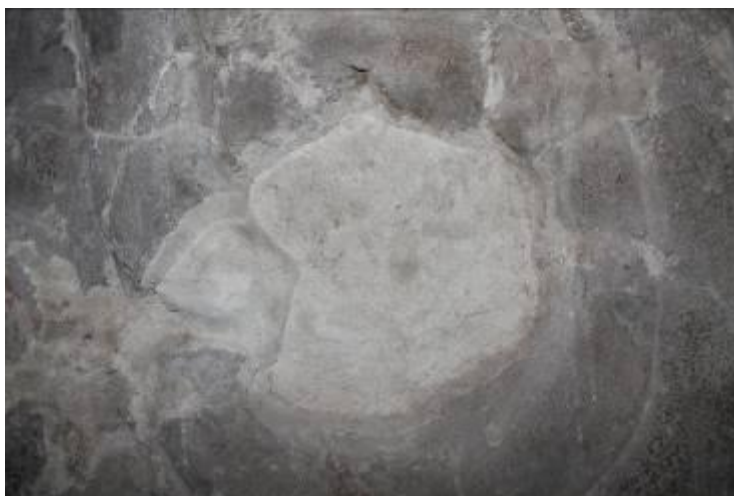
Figura 24. Zona abrasionada después del proceso. (Foto: M. Colín, 2013).
