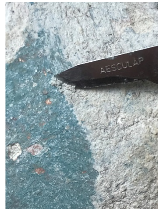
Figura 3.50. Limpieza de superficie con bisturí (Foto: M. Colín, PAET 2022).
