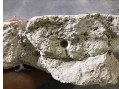
Figura 3.23. Perforaciones hechas en el núcleo de piedra para colocar los pernos (Foto: M. Colín, PAET 2022).
