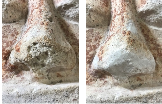
Figura 3.36. a) Izquierda: Detalle de la nariz desportillada y con fisuras. b) Derecha: Punta de la nariz resanada (Fotos: M. Colín, PAET 2022).
