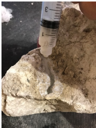
Figura 3.38. a) Izquierda: Aplicación de lechada en grieta en parte posterior de cabeza. b) Centro: Resane de grieta. c) Derecha: Parte posterior de cabeza estabilizada por consolidación y resane (Fotos: M. Colín, PAET 2022).
