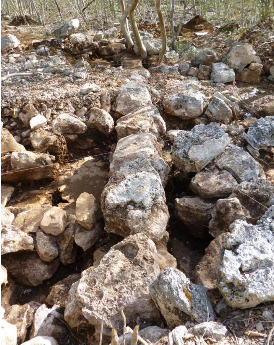
Figura 5.3d: Estructura 42s2, muro este, mirando al norte.
