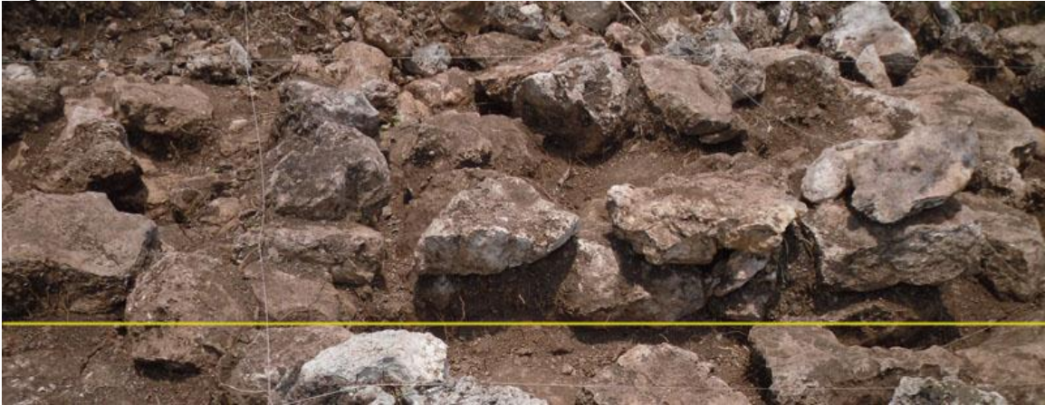
Figura 4.11: Muro 2 (arriba de la línea amarilla), mirando al oeste, estructura 8a.
