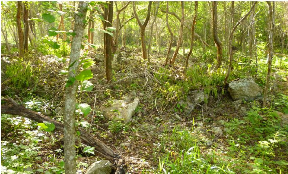
Figura 2.10: Foto de la esquina suroeste de la estructura KN85, mirando al este, mostrando piedra megalíticas. La plataforma está a la izquierda.
