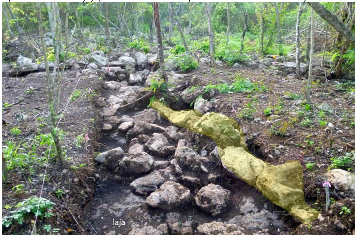
Figura 3.3k: Cima de 66n1, mostrando el lado norte del sacbé, mirando al este. La línea de piedras amarillas es el muro de retención del sacbé. Las piedras a la izquierda de la línea son derrumbe del sacbé. Se nota que el nivel alto de la laja y que el derrumbe del sacbé queda directamente encima de la laja.
