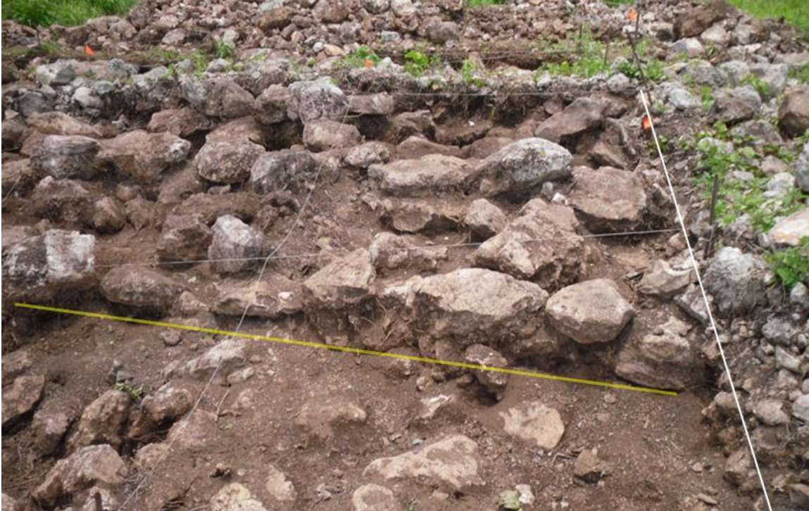
Figura 4.8: Muro 1 (directamente arriba de la línea amarilla), mirando al este, Op. 1A, Estructura 8a, Santa Teresa.
