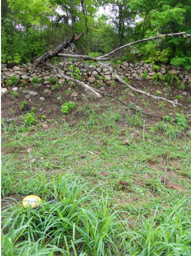
Figura 3.4b: Op. 4A, foto inicial, mirando al este. La albarrada de piedra esta arriba del derrumbe del lado oeste de la estructura 6.
