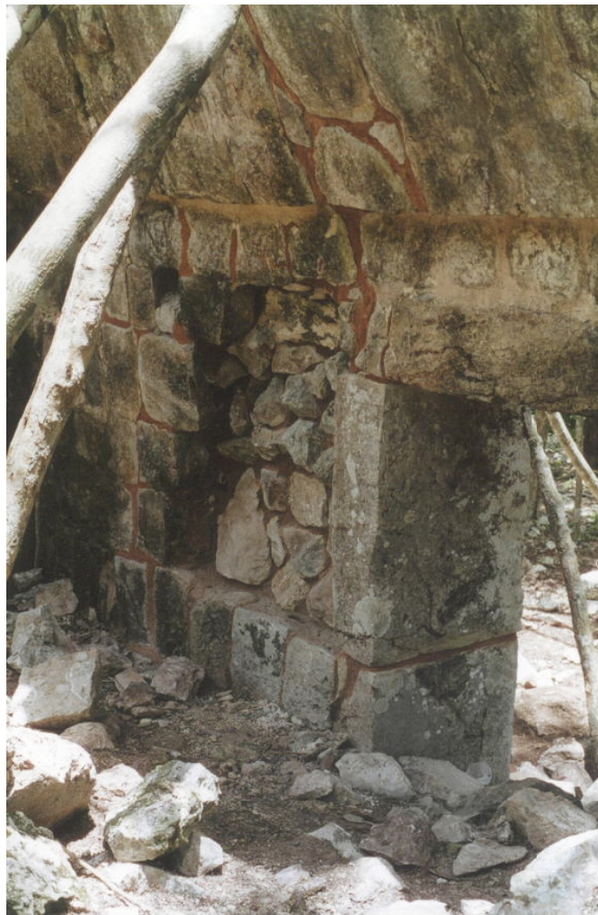
Figura 6.23. “Las Jambas Poderosas” Interior del cuarto 2 después de su consolidación.
