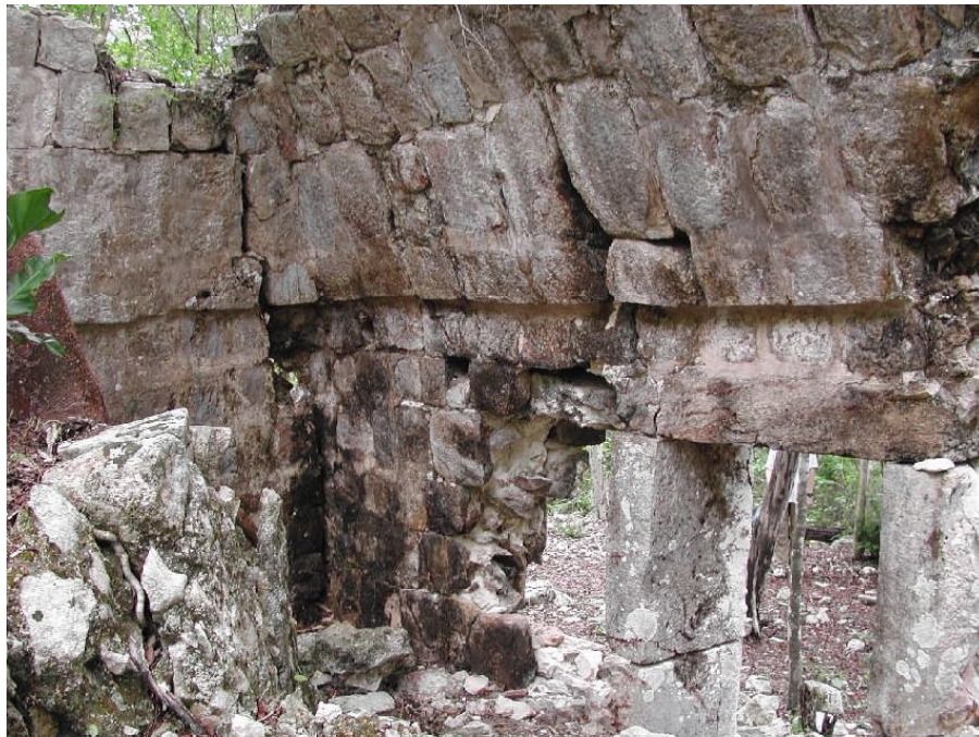
Figura 6.19. Interior del cuarto 2 de la estructura de las jambas poderosas antes de su consolidación.
