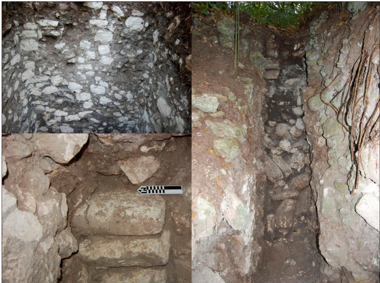
Figura 6. Revestimientos de piedra, diversas etapas constructivas, en la división que separa el Reservoirio del Palacio del Reservoirio Escondido (foto: L. Grazioso 2010).
