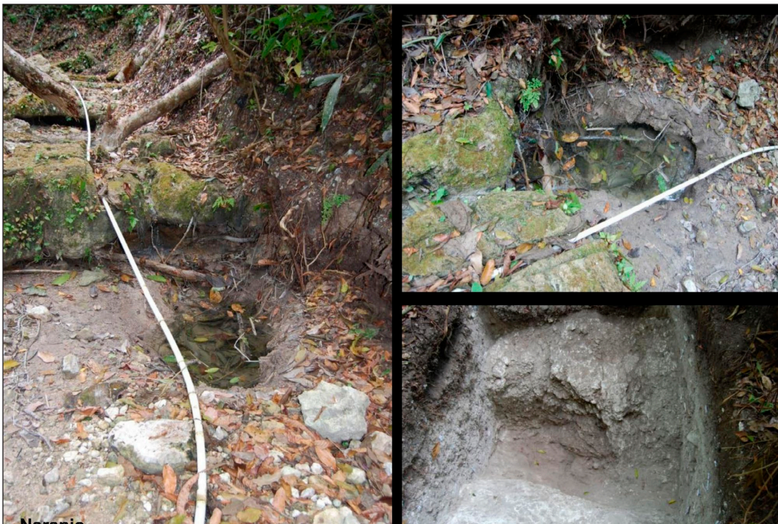
Figura 8. Manantiales activos en Naranjo (izq. y sup. der.). Fisura semicircular en el fondo del canal del Reservorio del Palacio (inf. der.) (foto: L. Grazioso 2010).
