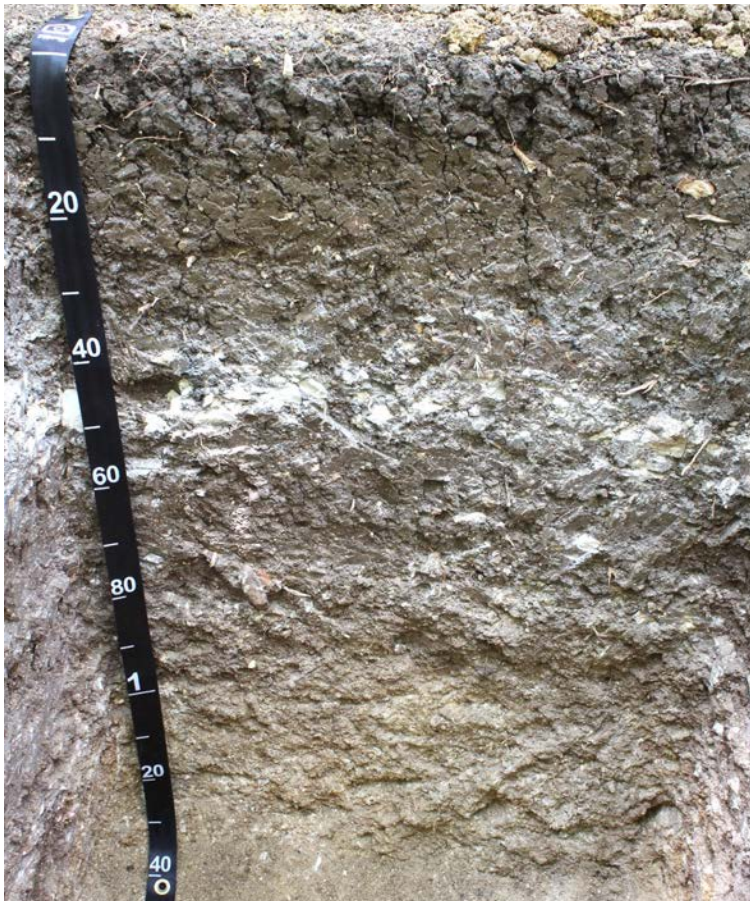
Figura 3.12 WK21A-5 perfil oeste del pozo (cinta en cm) que muestra el lavado de la pendiente posterior al abandono (0-0.40m) sobre depósitos culturales mayas (adoquines de piedra caliza y arcilla dragada de bajo 0.40-0.80m) y sascab de piedra caliza erosionada (0.80m - piso de pozo). El lecho de roca caliza consolidado está en el fondo del pozo. Foto de M. Ricker.
