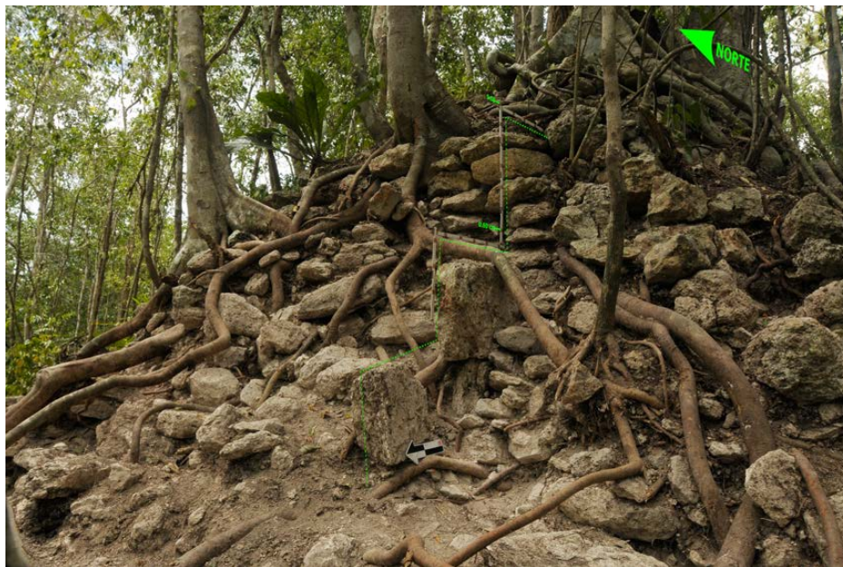
Figura 3.12. Losetas sobrevivientes in situ del paramento occidental de la escalinata de la Estructura A1 (Foto: A. Godoy, PAET; presentación: M. Rangel).
