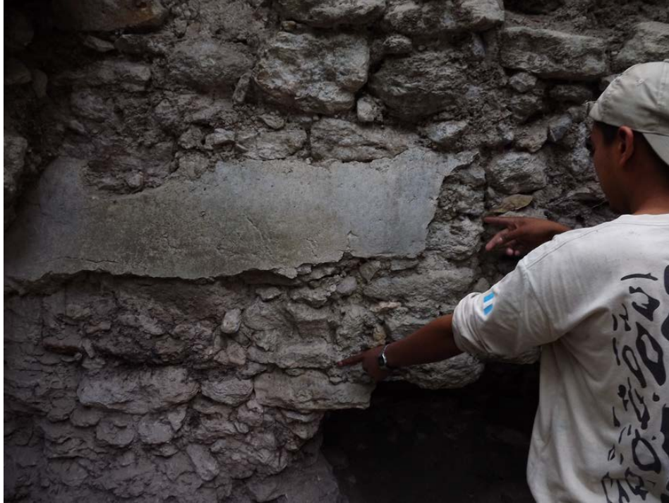
Figura 4.37b. Arriba se muestra el muro que separa los cuartos sur y norte del extremo este de la Estructura 13K-4, depredado por los saqueadores. Abajo, Daniel Vanegas muestra una posible conexión tapiada entre ambos cuartos (Fotos: V. Matute, PAET).
