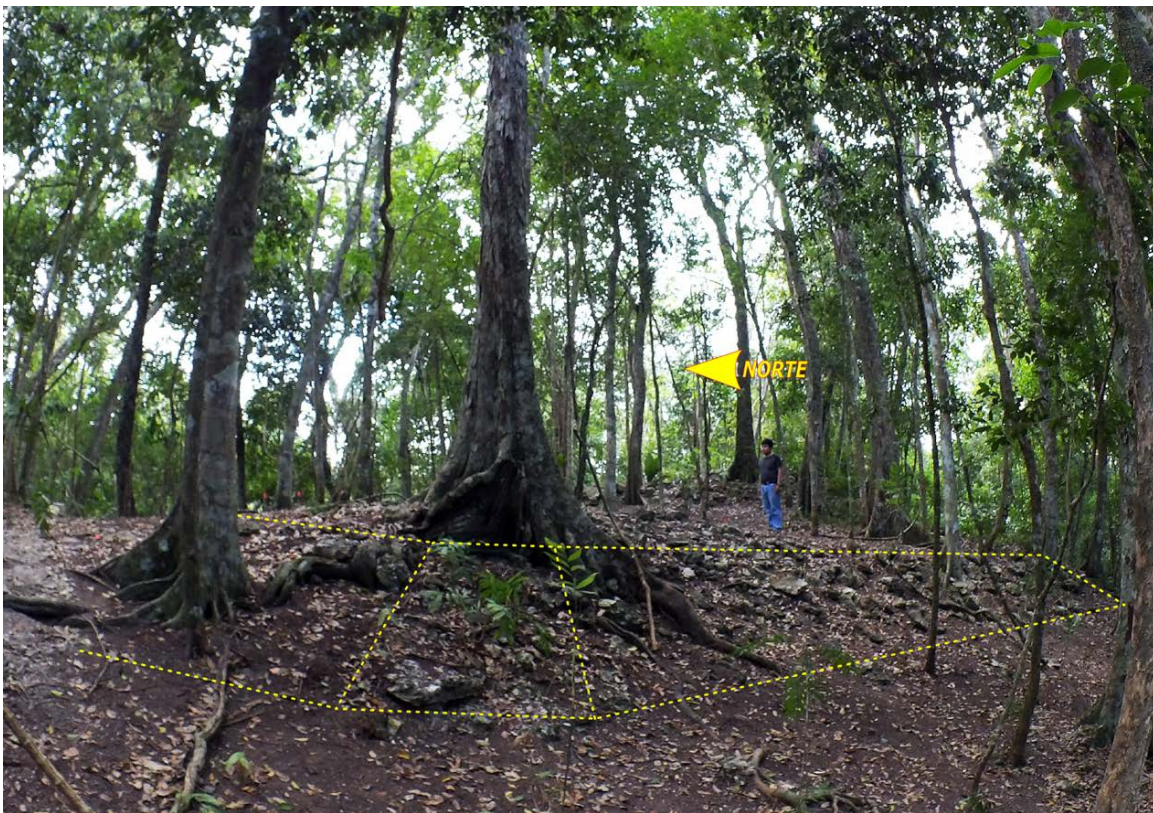
Foto 4.1. Hileras semicolapsadas de piedras a nivel de superficie, que definen el borde oeste y la esquina noroeste de la Plataforma B1. Atrás de la escala humana se puede apreciar la Estructura B3 (Foto y edición: M. Rangel, PAET).
