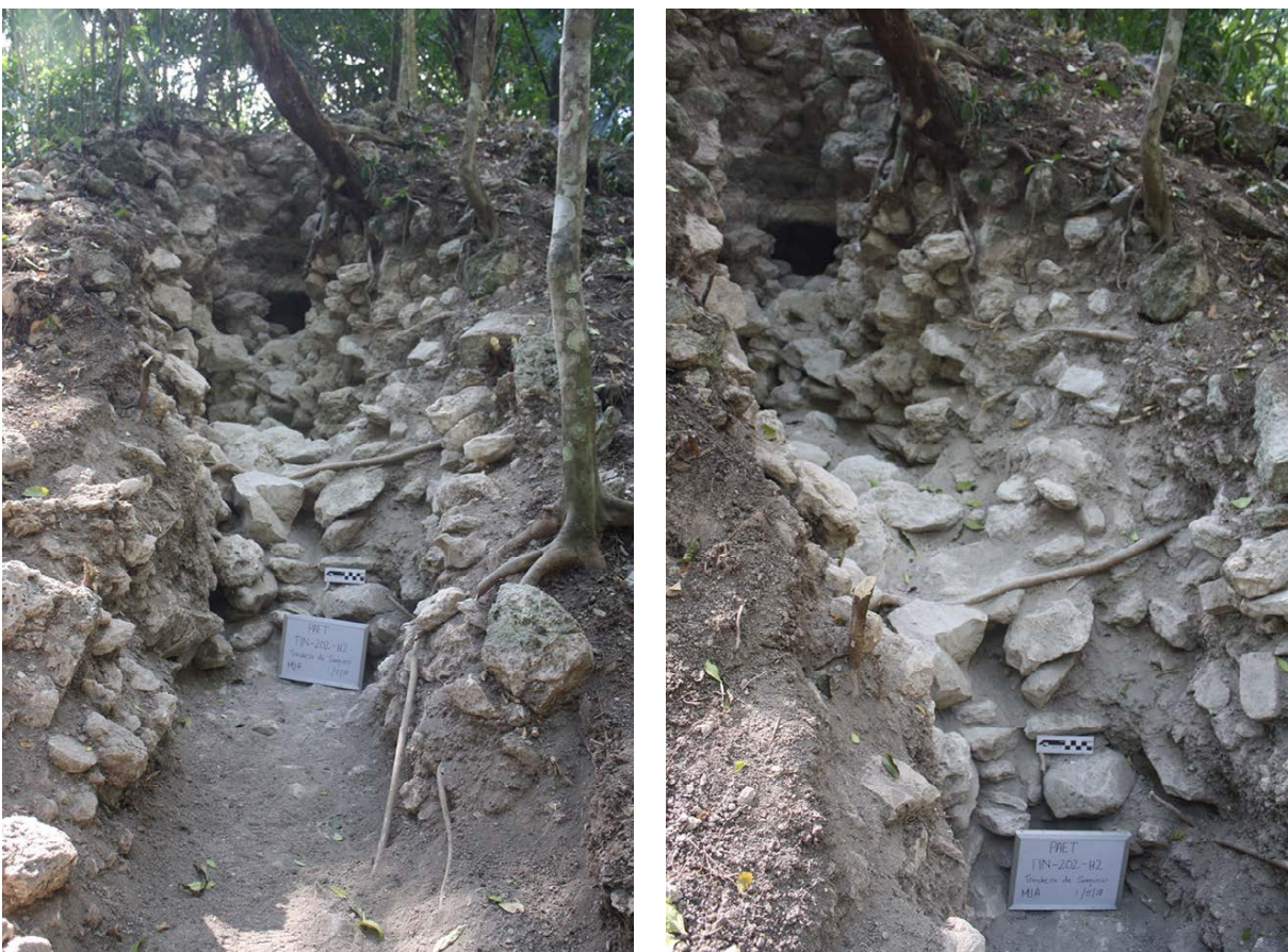
Foto 3.6. Fotografías de la trinchera de saqueo y Unidad TIN-202-H2 mostrando la destrucción causada a la arquitectura de Tz'unun (Fotos: M. J. Acuña, PAET).
