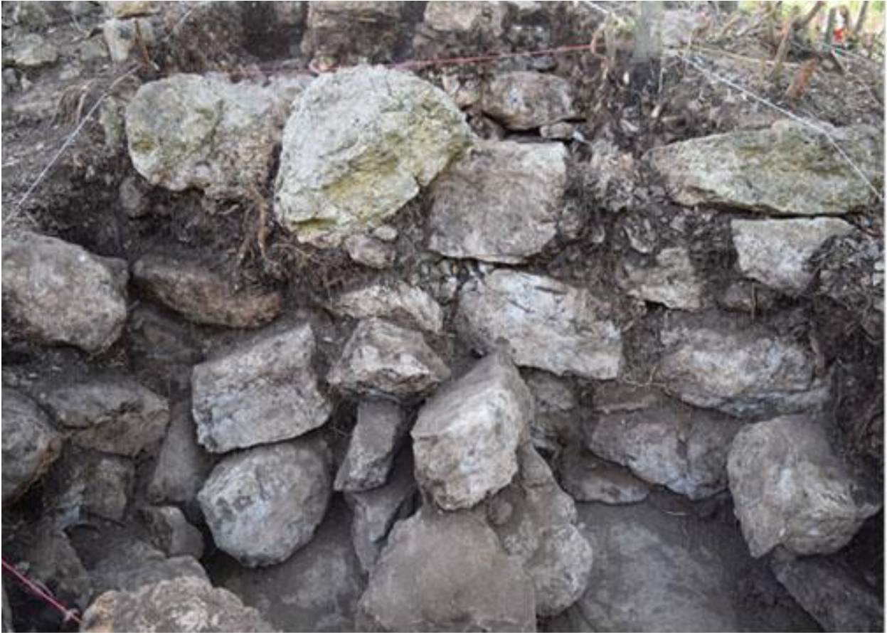
Figura 4.10: Foto del muro interior, mirando al este.
