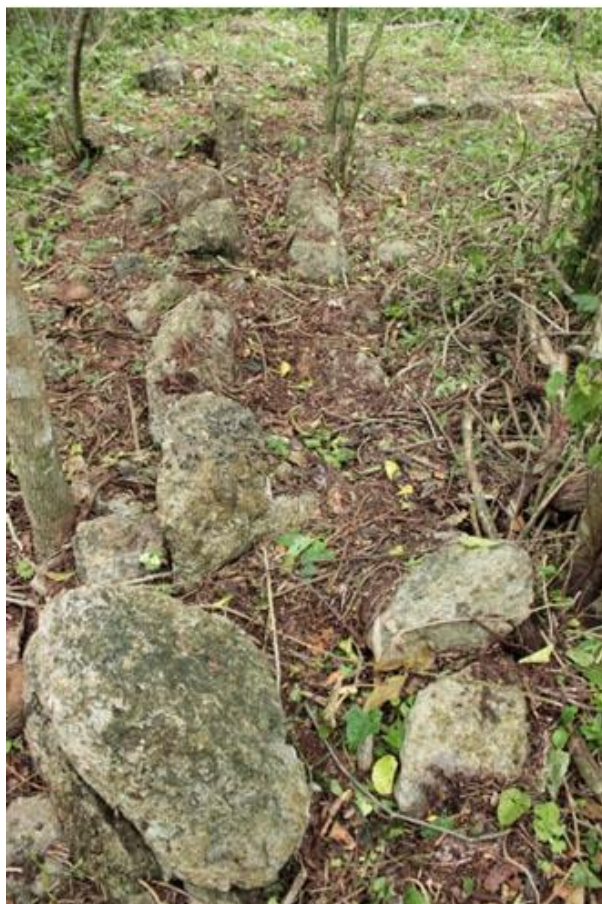
Figura 6.51: Vista de N588C, desde su esquina noroeste. Se ve su muro de doble marco y el muro de retención de su super-estructura (588D)
