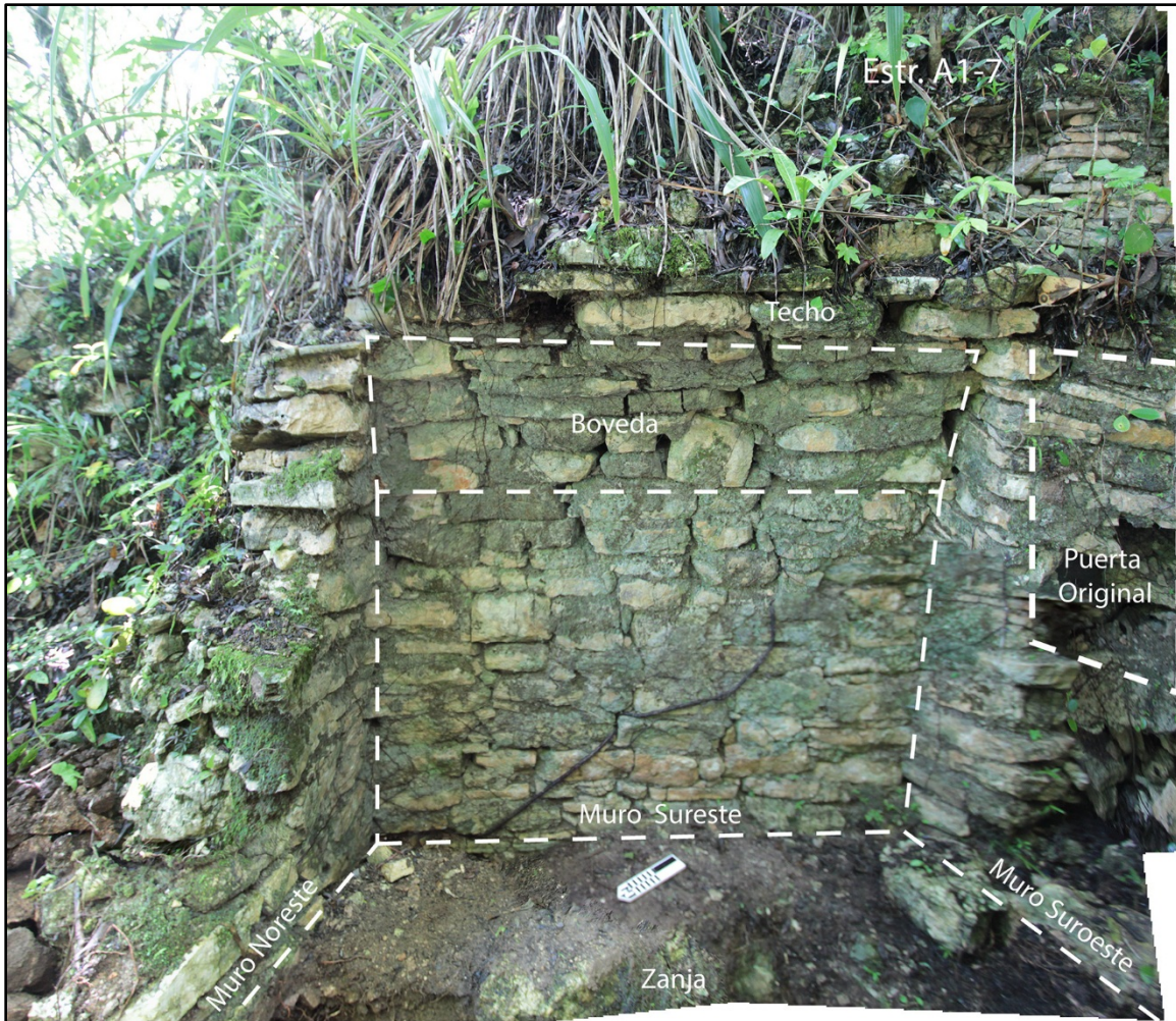
Figura 5.4 Cisterna abovedada actualmente derrumbada. Apparently existía una entrada en la pared suroeste, en forma de puerta o ventana, bajando desde la Estructura A1-7. El desagüe tiene su salida al noreste (foto por C. Golden).
