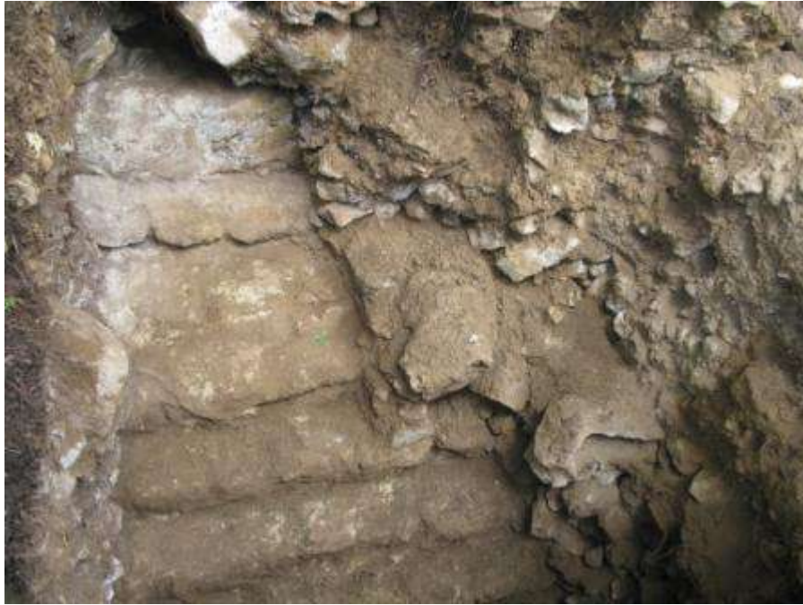
Figura 7.13. Foto tomada del oeste donde se muestra la escalinata y la banqueta en su penúltima fase constructiva el lote 7 (CR 32-H-3-7). (Foto por Antolín Velásquez)
