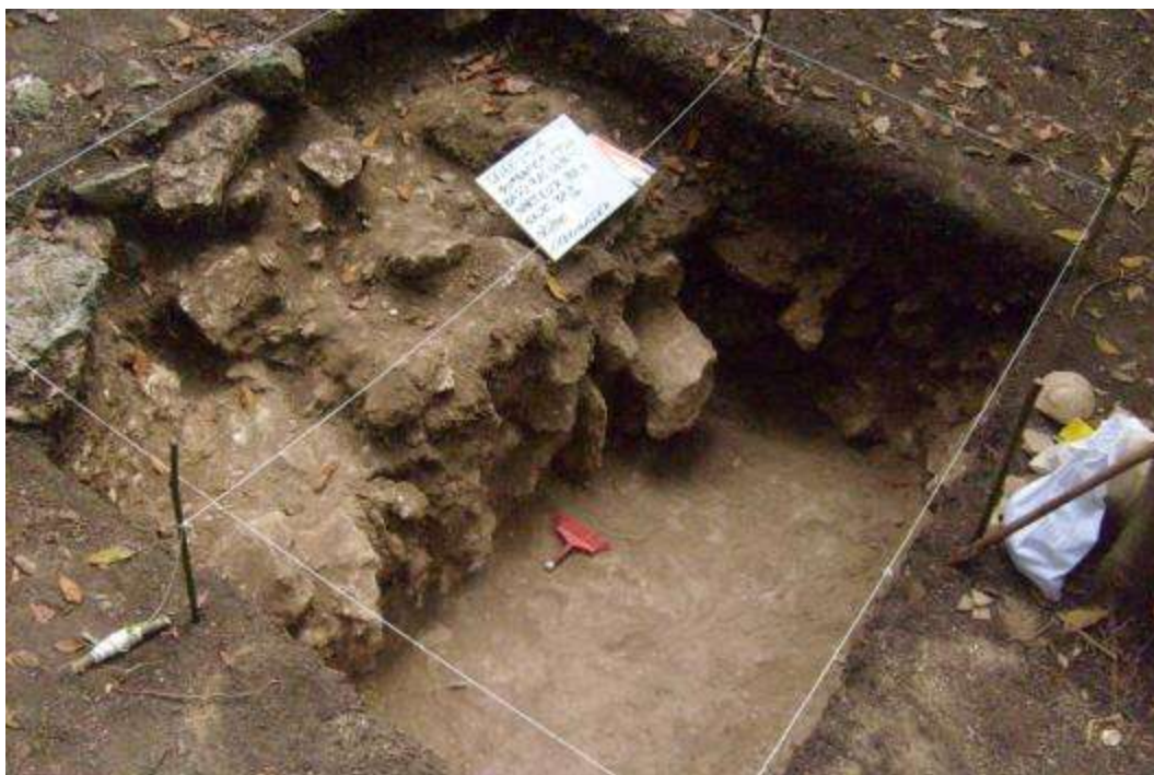
Figura 10.12 Muro colapsado y apisonado en la fachada norte de la Estructura 13R-10 (Fotografía por Carlos E. Fernández)
