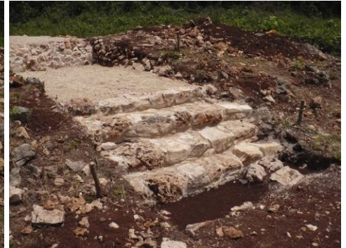
Fig. 10. 49. Operación 167: Detalle de la escalinata.
