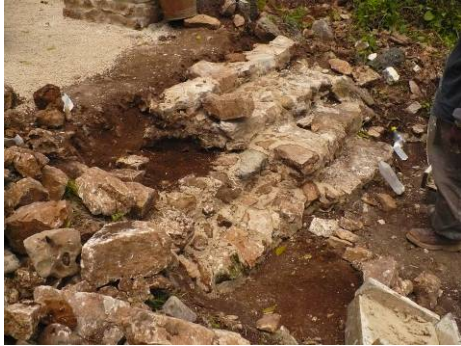
Fig. 10. 16. Operación 161: Colocación y consolidación del núcleo en la porción faltante de la escalinata superior en el Edificio 4.
