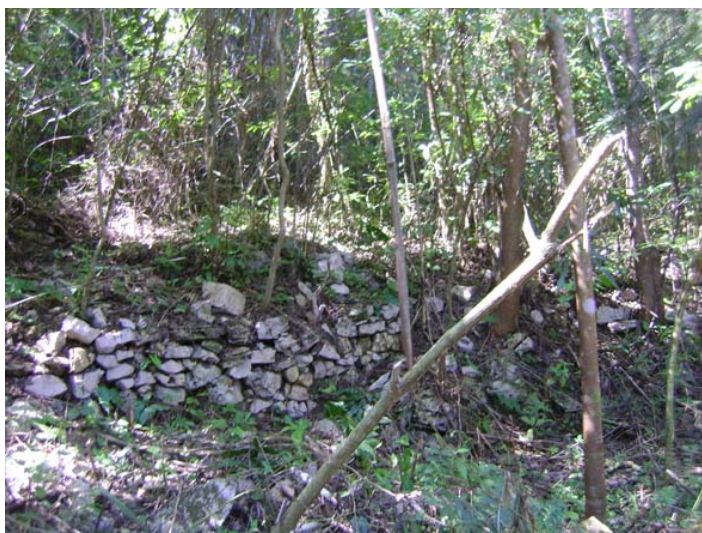
Fig. 2. 19. Mampostería de la estr. I-11 del conjunto CHK/I120 (foto A. Campiani)
