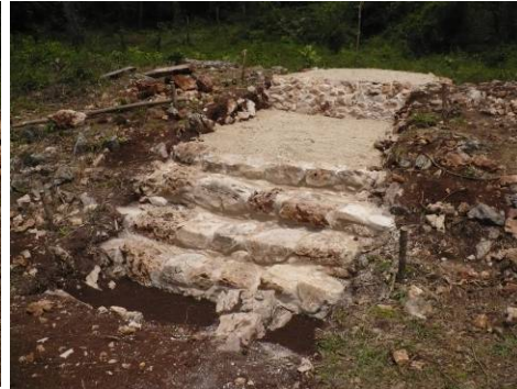
Fig. 10. 48. Operación 167: Vista general de la cala, con la escalinata ya consolidada y la colocación de gravilla de sasacab .
