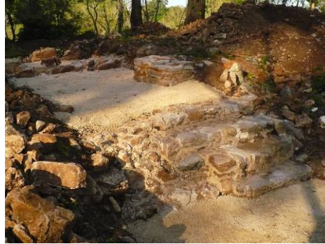
Fig. 10. 17. Operación 161: Proceso concluido de la consolidación de la escalinata superior del Edificio 4.
