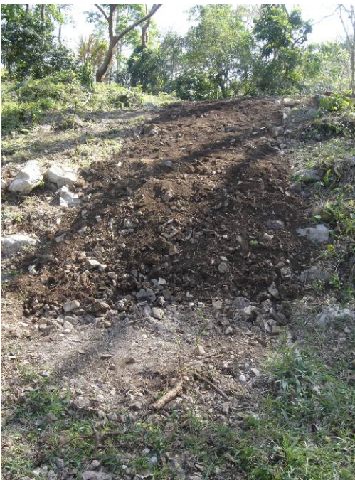
Fig. 10. 46C. Operación 161. Finalización de las labores de relleno.
