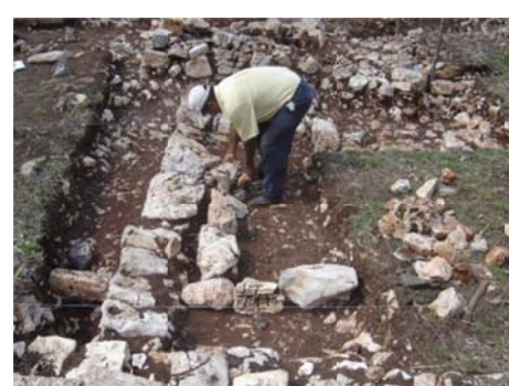
Fig. 3.151. Proceso de protección de rasgos arquitectónicos.
