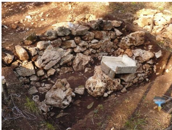
Fig. 10. 50. Operación 167: Limpieza y saneamiento de juntas del muro posterior del Edificio C-5b
