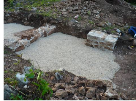
Fig. 10. 21. Operación 161: Aspecto del recinto, al término de la consolidación, al cual se le incorporó una capa de gravilla de sascab para indicar la ubicación del nivel de piso.
