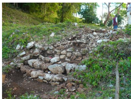
Fig. 10. 3A. Operación 16: Retiro de escombro de la escalinata del Edificio 4.
