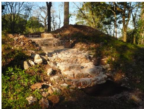
Fig. 10. 10. Operación 161: Detalle de la escalinata una vez concluido el proceso de consolidación
