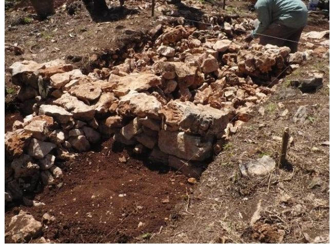
Fig. 10. 53. Operación 167: Relleno de las cajas alternando capas de tierra y piedra.
