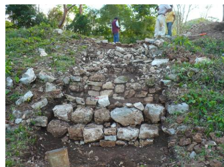
Fig. 10. 3B. Operación 16: Saneamiento de juntas en la escalinata del Edificio 4.
