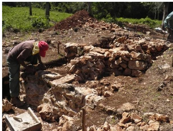
Fig. 10. 51. Operación 167: Consolidación del muro posterior del Edificio C-5b y colocación de la caja para su relleno.
