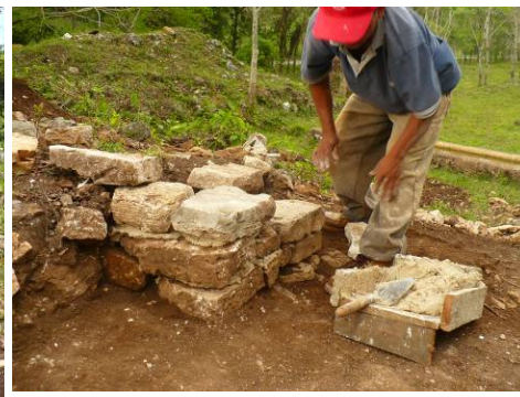
Fig. 10. 19. Operación 161: Consolidación del vano de acceso al recinto de Edificio 4
