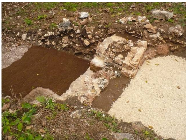
Fig. 10. 40. Operación 161: Detalle de la consolidación del núcleo en el muro posterior
