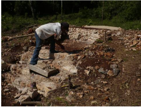
Fig. 10. 47. Operación 167: Consolidación de la escalinata del Edificio C-5b.
