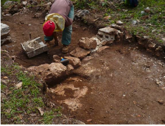
Fig. 10. 25. Operación 161: Limpieza de juntas y consolidación del muro medianero.
