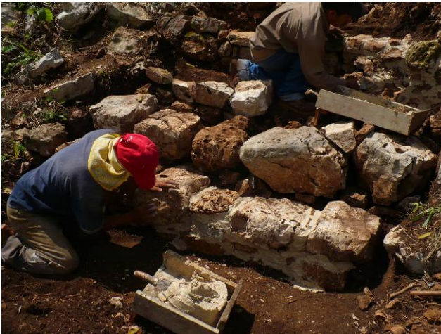
Fig. 10. 6. Operación 16: Reposición de juntas en la escalinata del basamento del Edificio 4.
