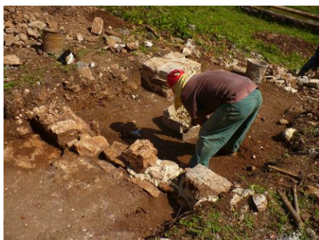
Fig. 10. 24. Operación 161: Consolidación del muro medianero.
