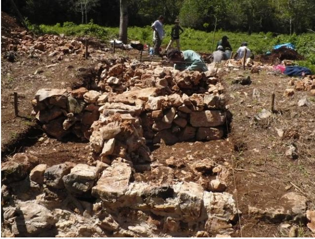
Fig. 10. 52. Operación 167: Detalle que muestra la colocación de muros secos para el armado de las cajas de relleno.
