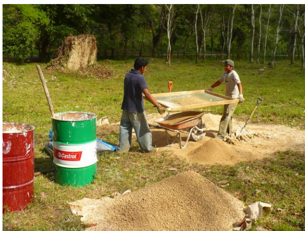
Fig. 10. 45. Operación 161: Tambos para el apagado de la cal y cribado de sascab para la preparación de mezclas.
