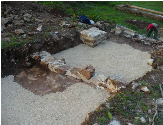
Fig. 10. 27. Operación 16: El piso de estuco quedó protegido mediante la aplicación de sascab bien cribado. Sobre éste se colocó una capa de gravilla de sascab , indicando así su nivel general.
