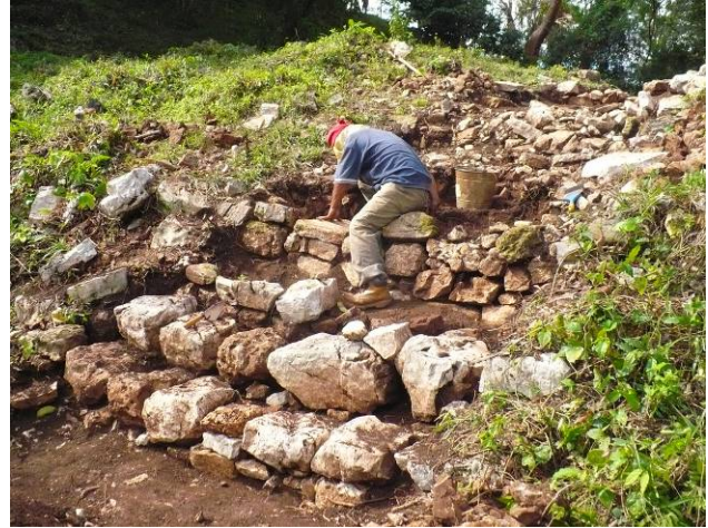
Fig. 10. 5. Operación 16: Reacomodo y alineación de los peldaños de la escalinata.
