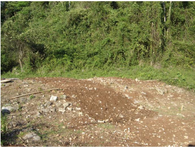
Fig. 10. 56. Operación 167. Finalización de las labores de relleno.
