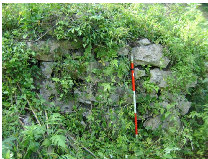
Fig. 2. 4. Parte de muro interior de la estr. K-17 (foto A. Campiani)
