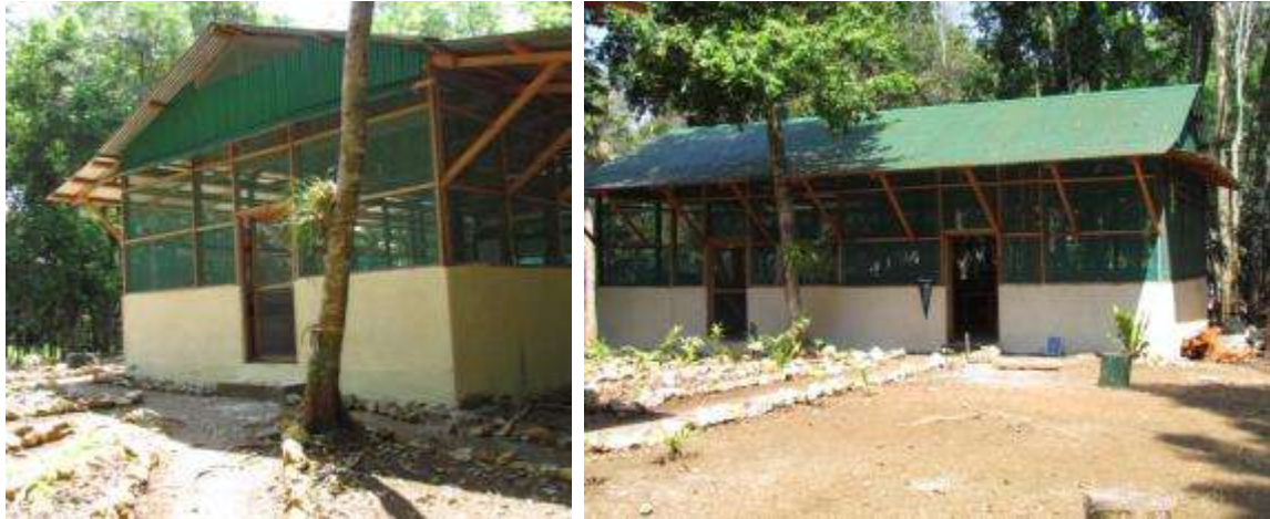
Figura 1.11 Edificios de oficina y bodega de materiales y herramientas, campamento PRALC (Foto por T. Barrientos)
