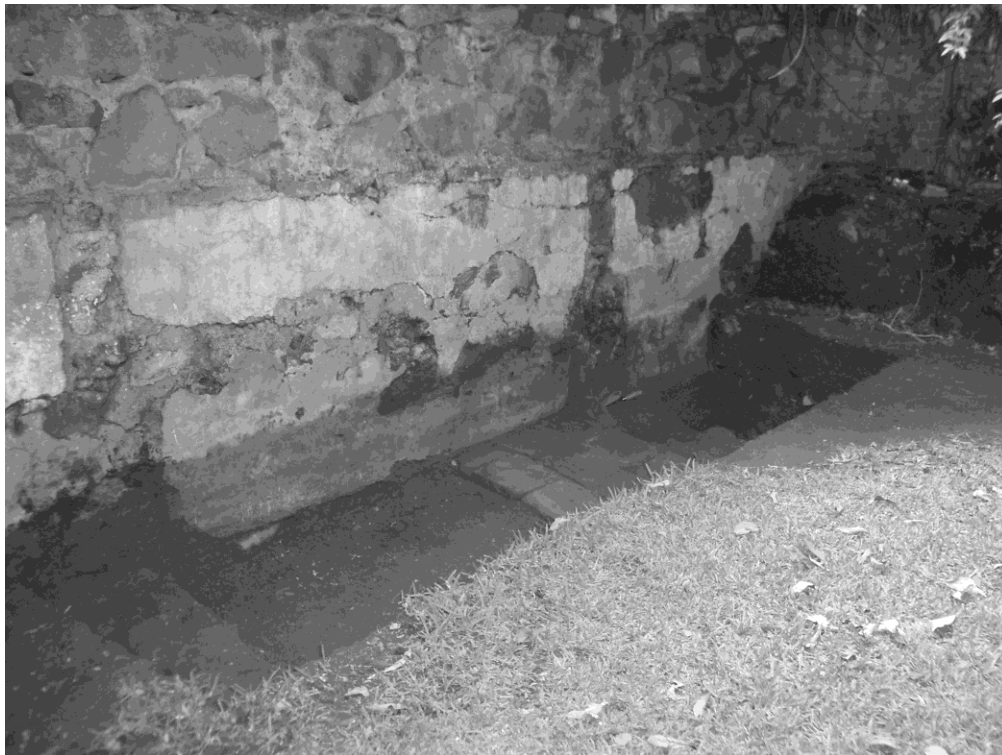
Figura 6 Vista General del Área de camas de la sala oeste del antiguo Claustro Mayor del Hospital Real de Santiago que evidencia la impronta de los tabiques en el muro de mampostería (Fotografía 2009).
