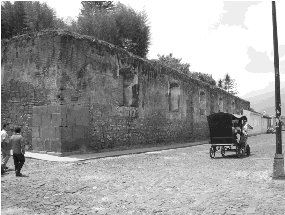
Figura 3 Vista General del muro perimetral oeste del antiguo Claustro Mayor del Hospital Real de Santiago, La Antigua, Guatemala (Fotografía Wolley 2009).
