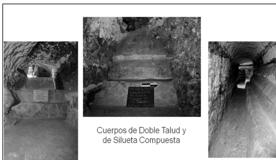
Figura 6 Rasgos arquitectónicos de las excavaciones en Jabalí. San Bartolo 2010.
