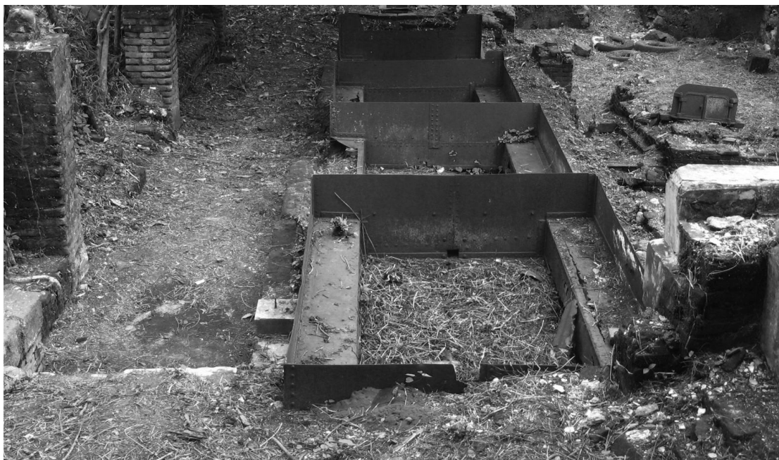
Figura 7 Tren jamaquino formado por máquinas térmicas o pailas.
