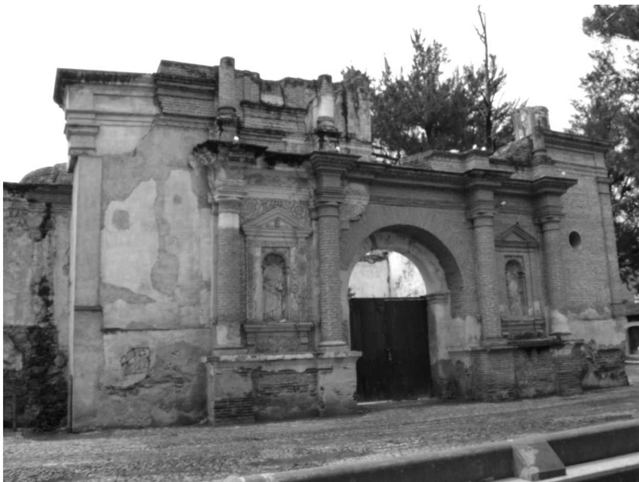
Figura 7 Templo de San Sebastián posterior a su restauración. Lamentablemente no se integró el revestimiento en la mampostería nueva
