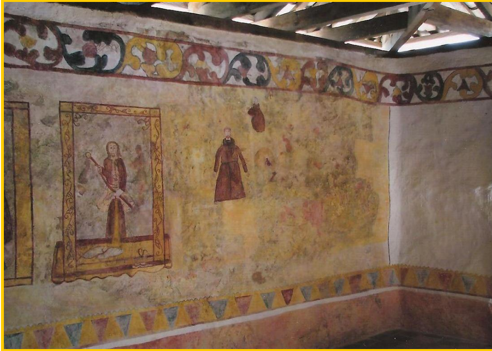
Figura 16 Muro Sur, interior Ermita del Soldado
