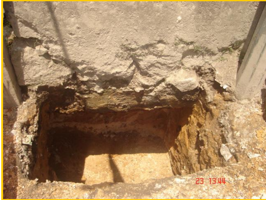
Figura 6 Excavaciones perimetrales, definición de cimientos
