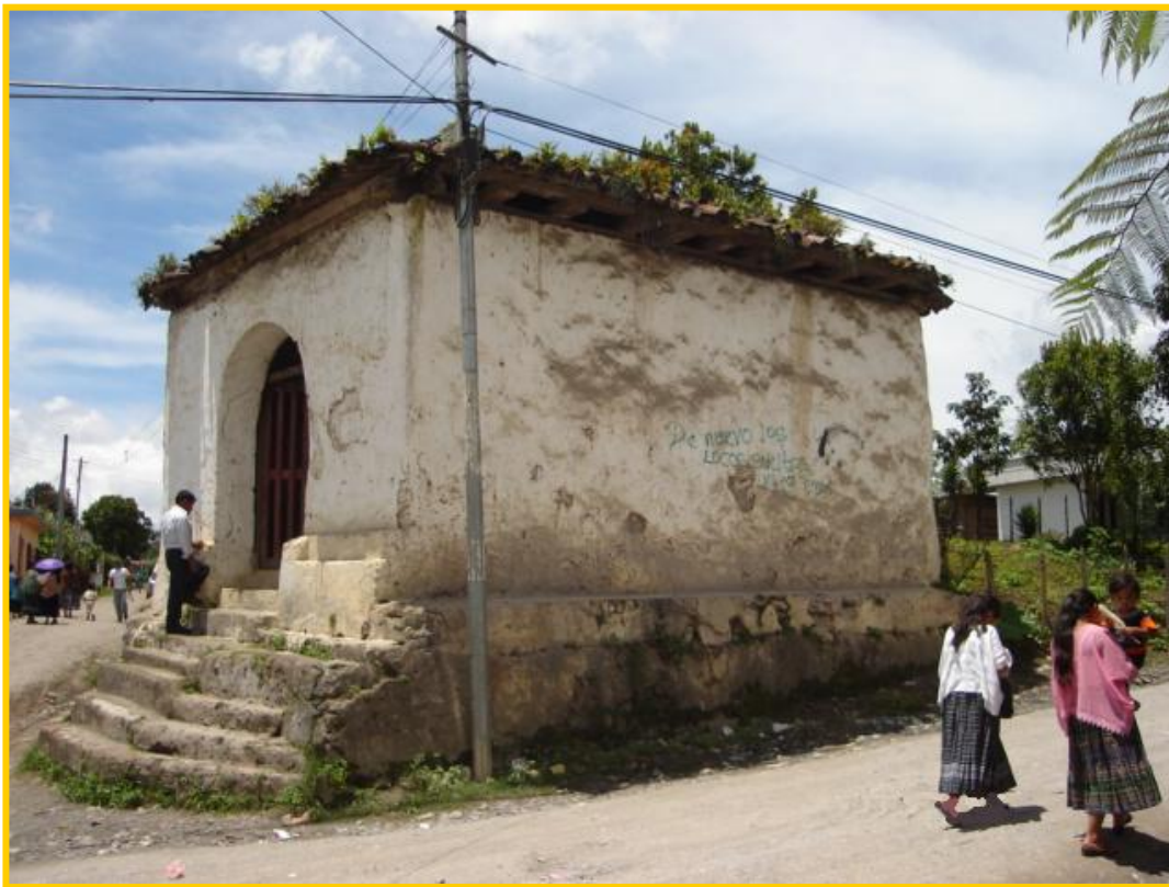
Figura 1 Ermita previo a Restauración
