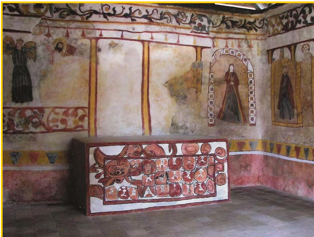
Figura 15 Muro Oriental, interior Ermita del Soldado
