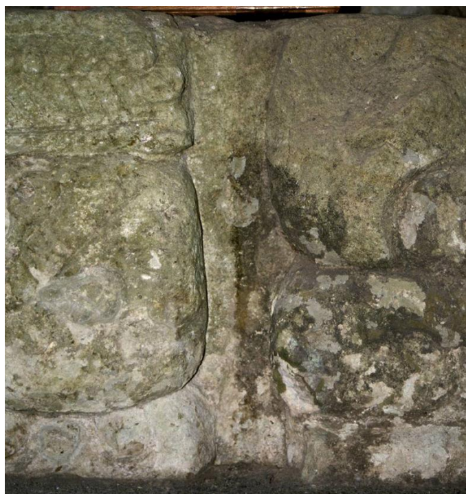
Figura 11 Una zona después de la limpieza, la reducción de los tratamientos anteriores con hisopos y acetona, y los nuevos tratamientos de estabilización a base de cal (izquierda); y una zona sin nuevo tratamiento (derecha; Foto por Elsa Bourguignon)
