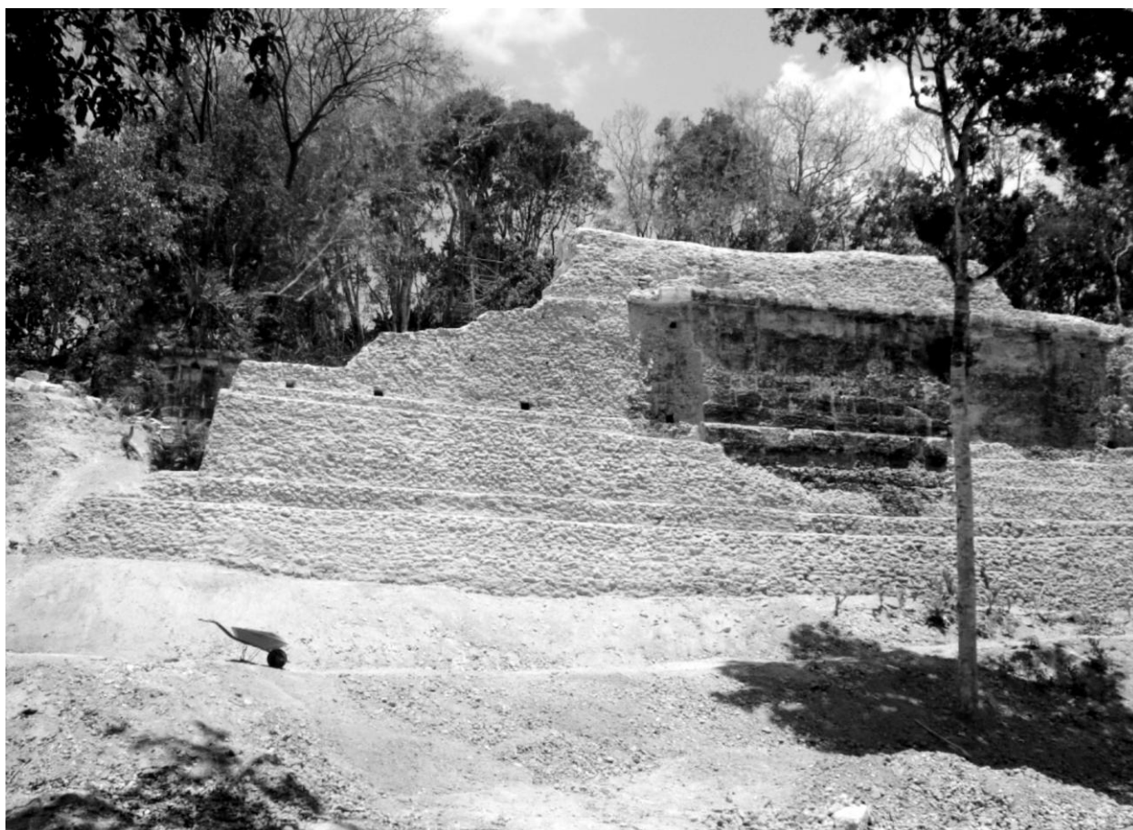
Figura 8 Edificio Q, Después de su intervención
