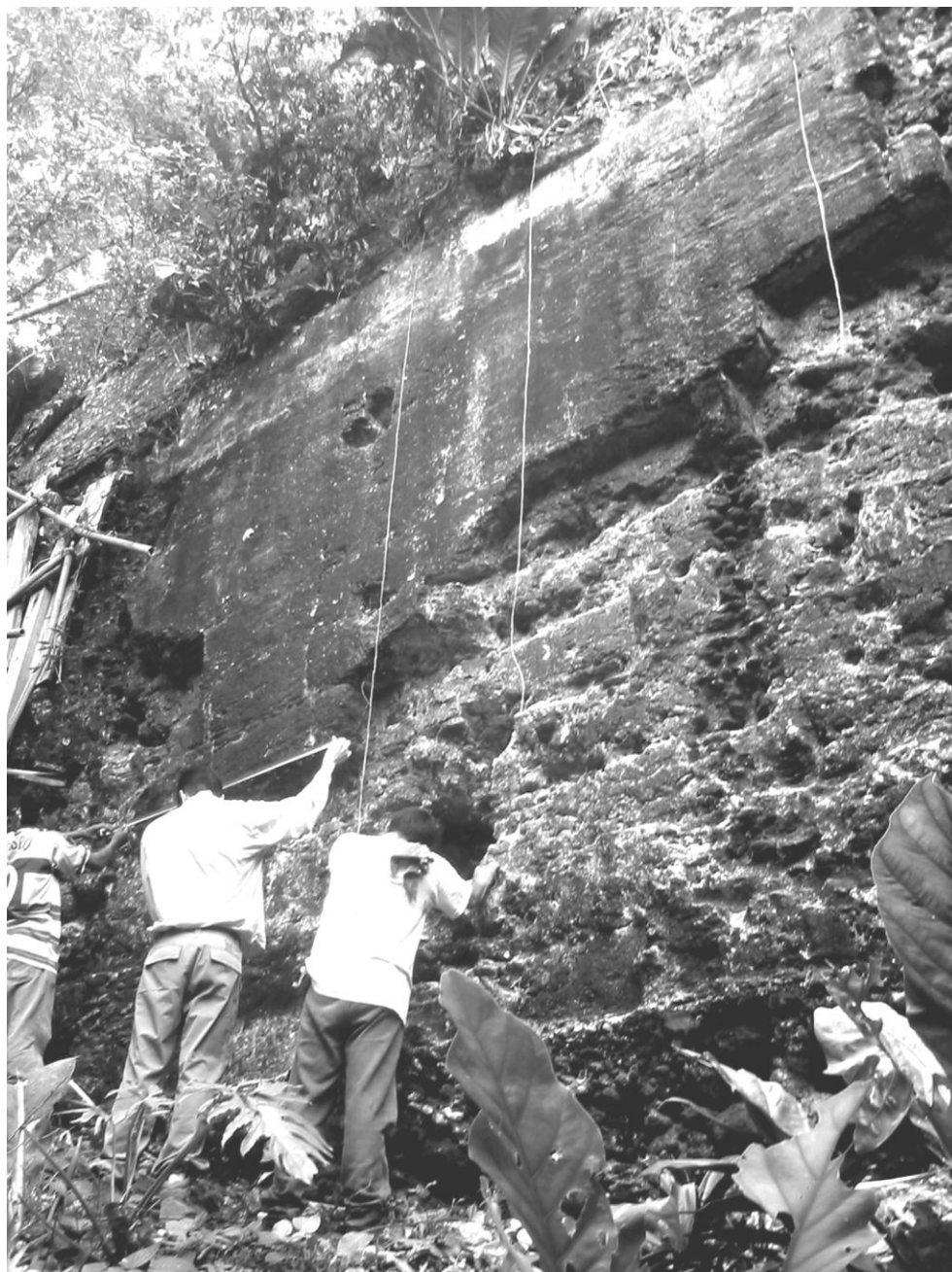
Figura 3 Muro posterior del palacio
