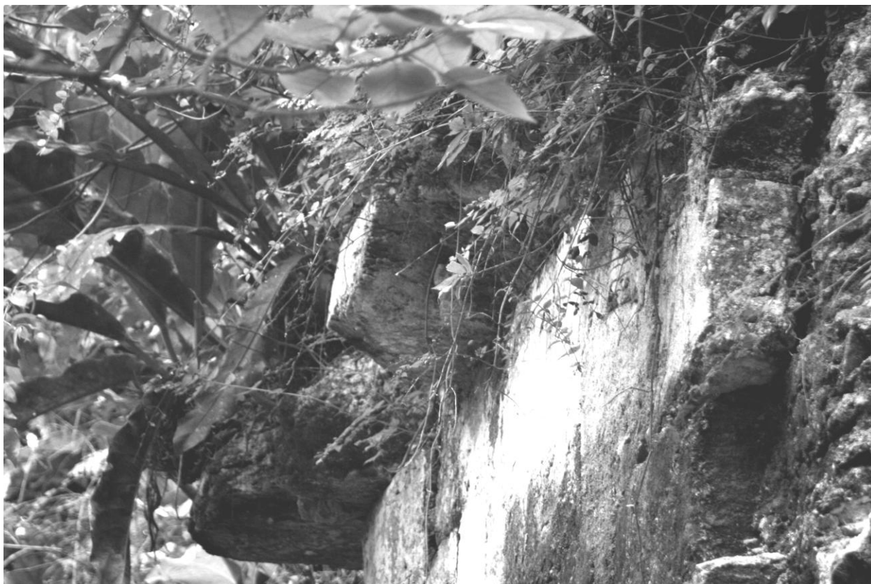
Figura 4 Detalle piedra de cornisa
