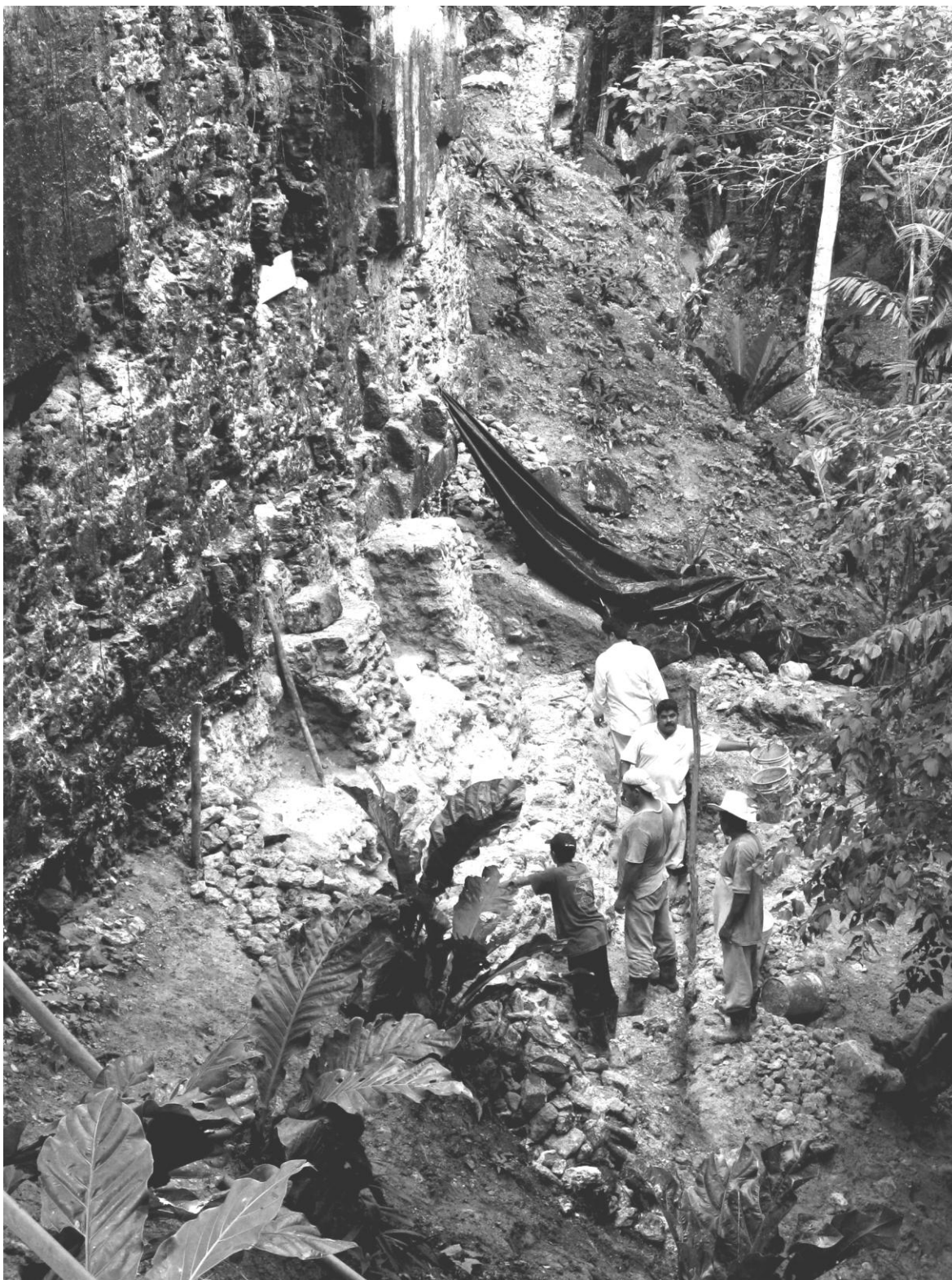
Figura 6 Recalce del muro oriental
