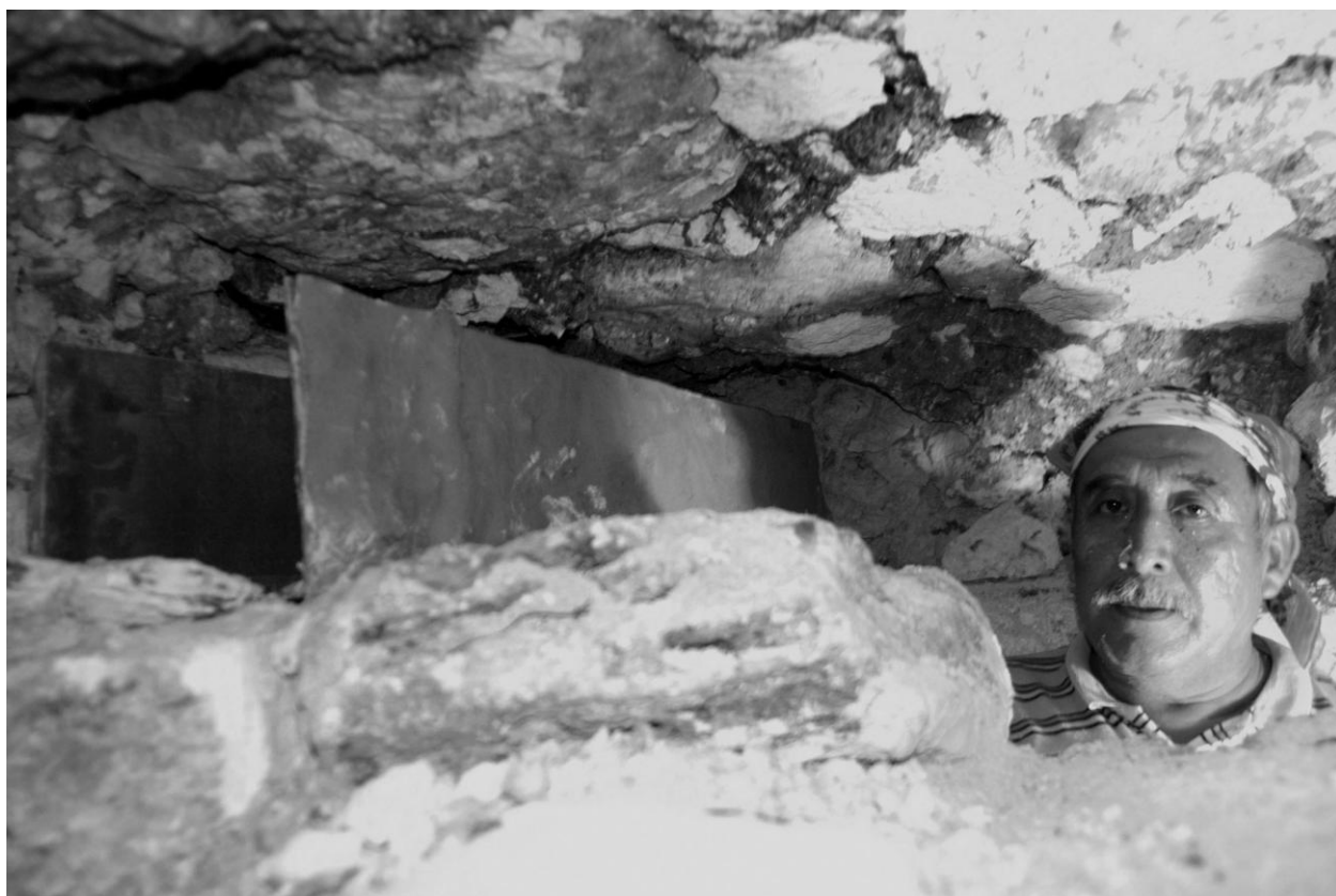
Figura 9 San Bartolo, canal colocado, aún sin relleno
