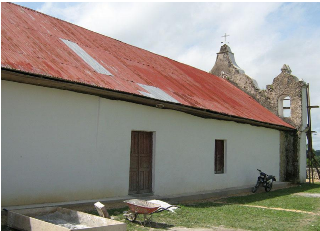
Figura 17 Vista lateral después de la intervención
