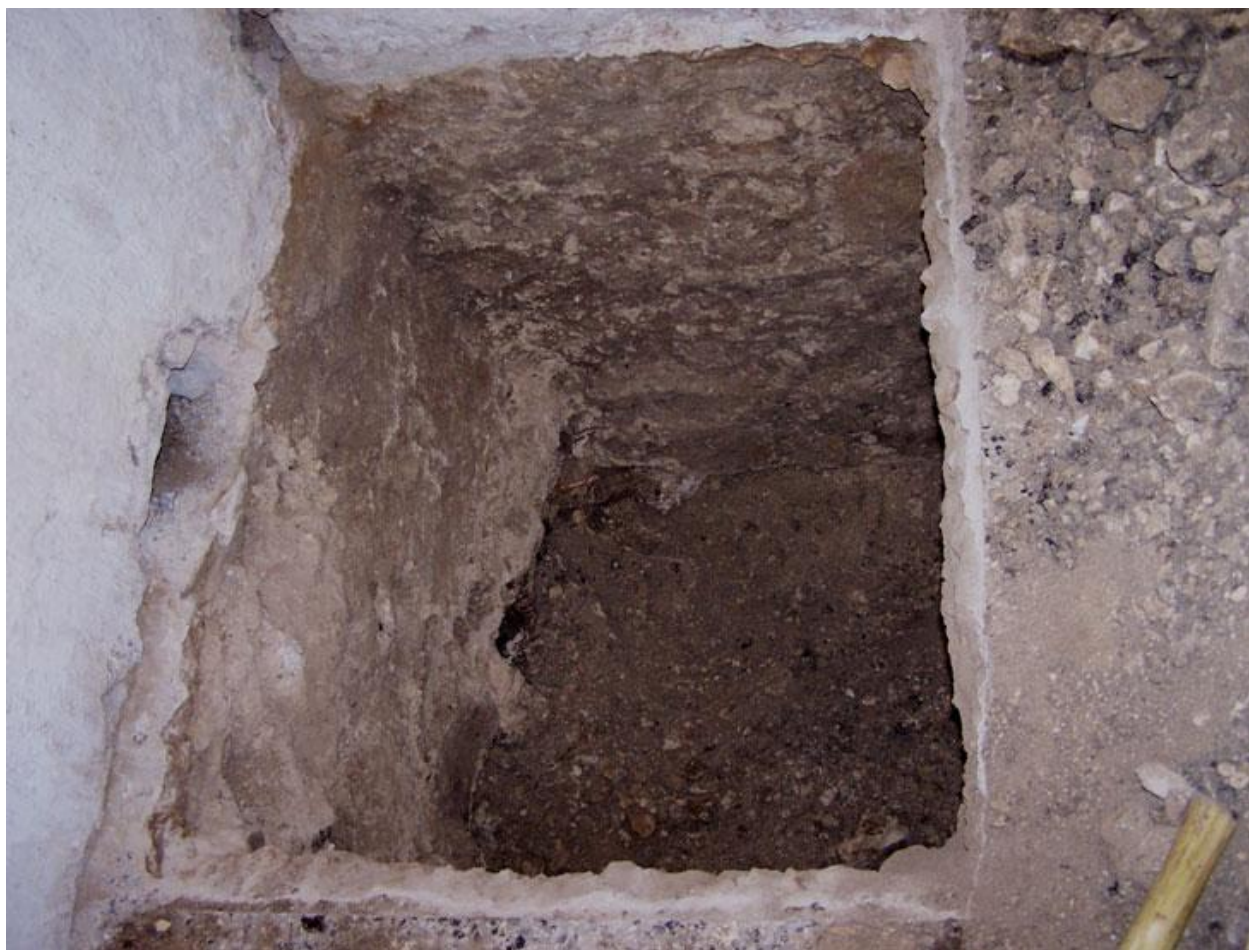
Figura 12 Cimentación en los registros
