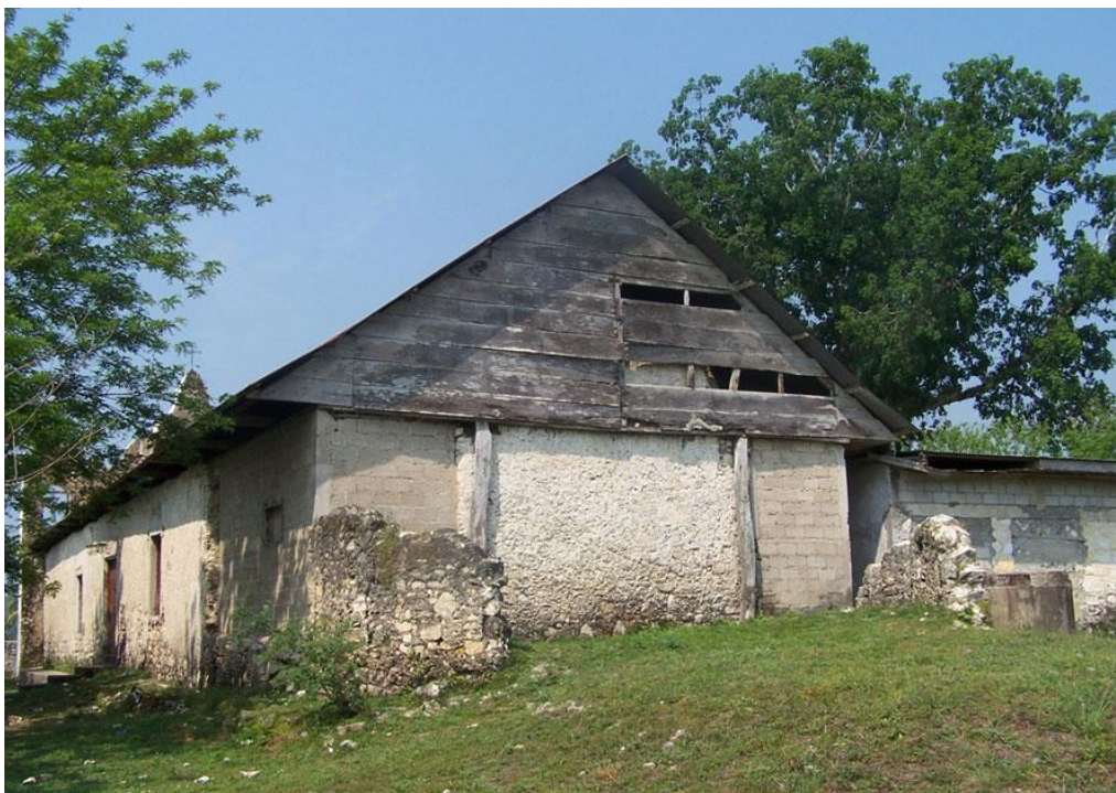
Figura 13 Vista posterior antes de la intervención
