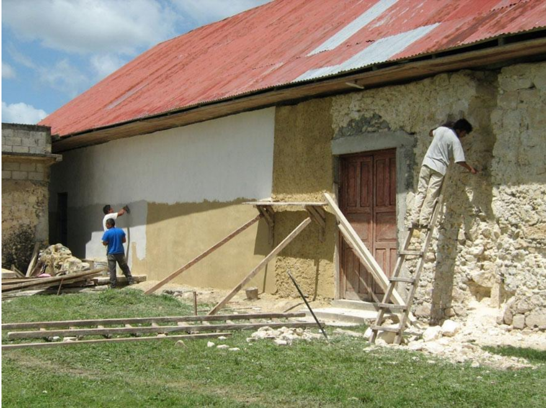
Figura 16 Vista lateral durante la intervención
