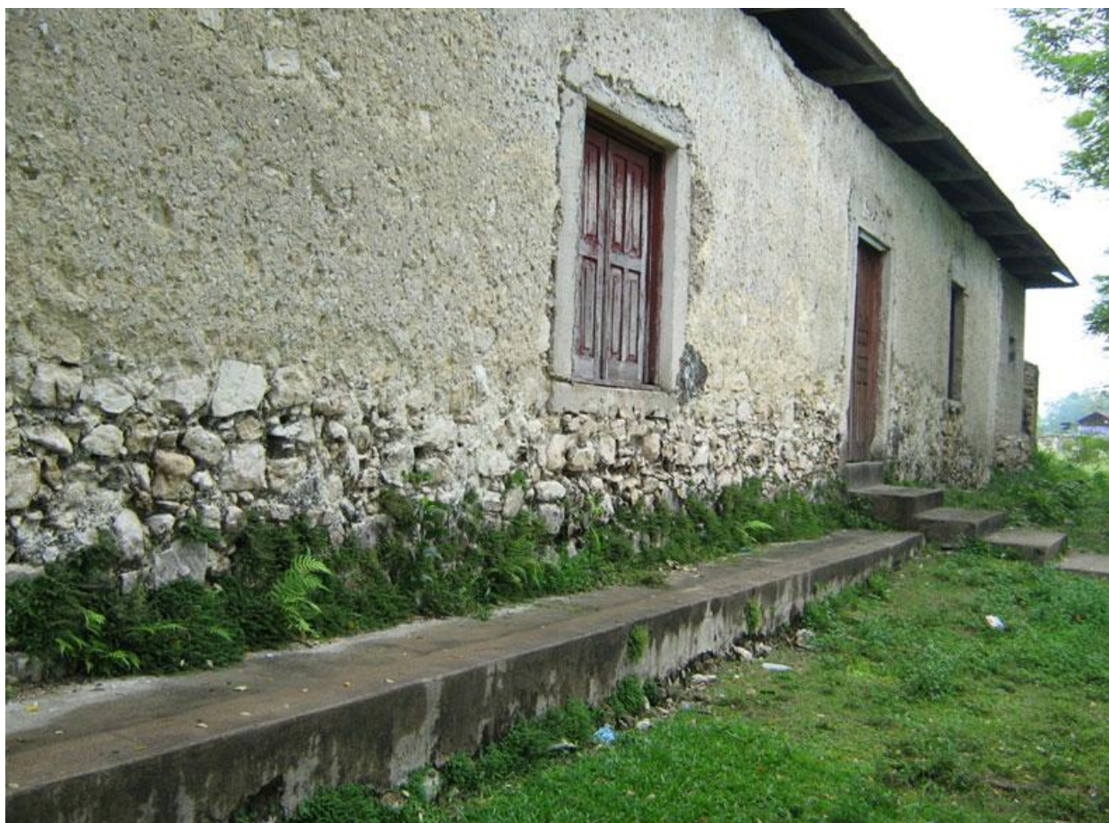
Figura 15 Vista lateral antes de la intervención
