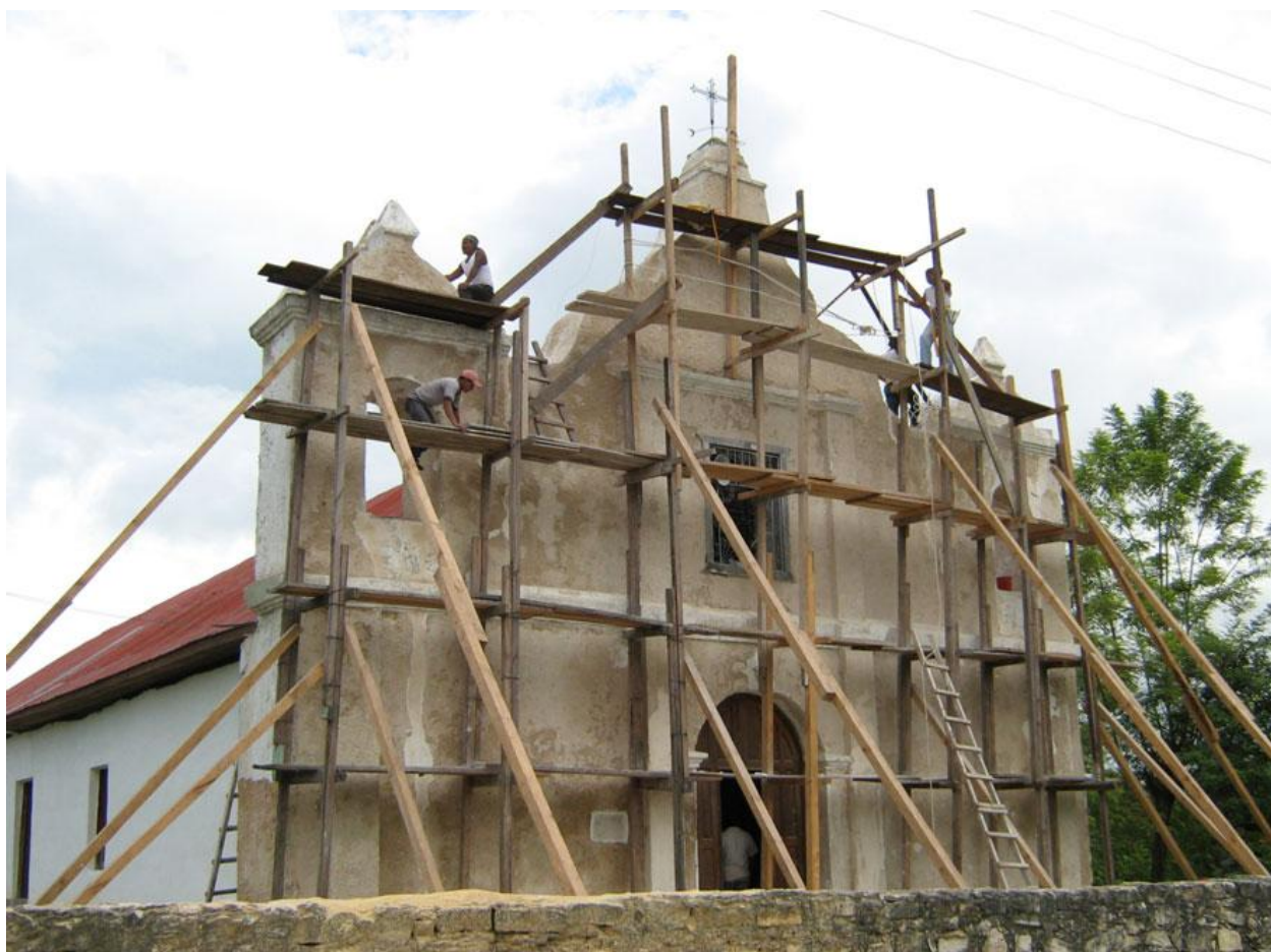
Figura 21 Fachada durante el proceso de intervención
