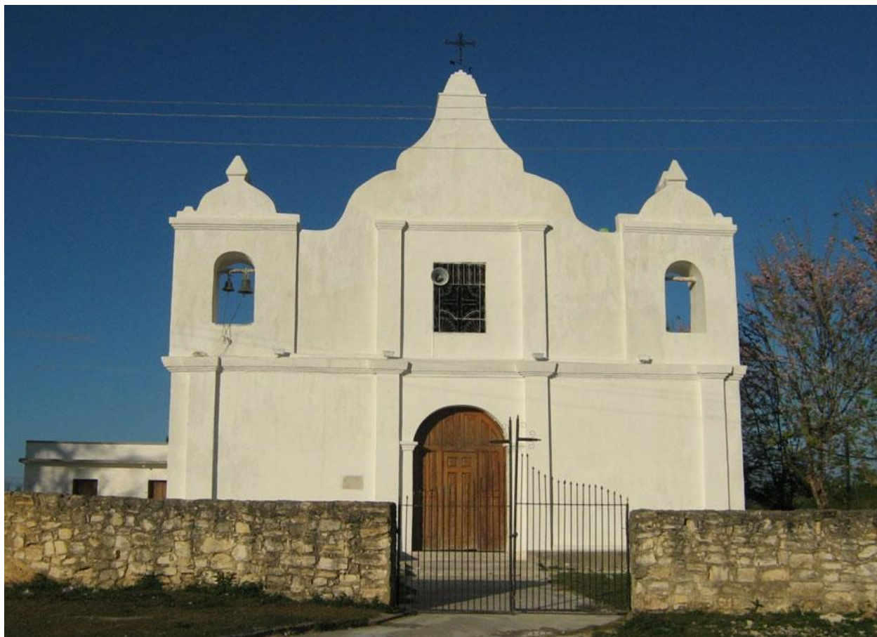
Figura 22 Fachada luego del proceso de intervención
