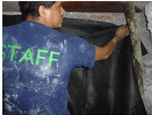
Fotos 6.12 y 6.13. Colocación de geotextil como protección (Fotografía: Edwin Pérez Robles 2016).
