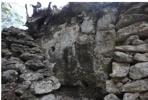
Figura 3.30. Grietas en la pared del primer cuarto del templo de M7-1.
