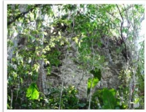
Foto 9. Vista del basamento del templo en el lado sur, se observa muy erosionado y dañado por el intemperismo; así mismo es posible ver algo de la vegetación grande que se encuentra en toda la superficie de la pirámide.
