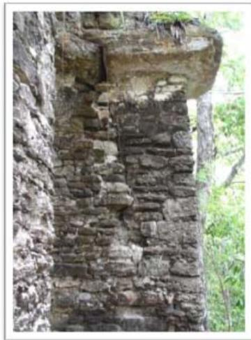
Foto 23. Obsérvese cómo el peso de la enorme piedra de cornisa ha provocado una seria fractura en el muro este del cuarto norte.
