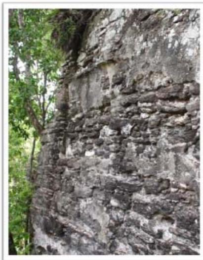
Foto 19. Detalle de la esquina sureste del templo vista desde el este, es notorio el desgaste de las piedras, la microflora que ha proliferado en la superficie y los faltantes en la parte superior.
