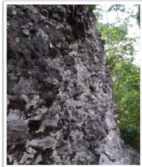
Foto 20. Superficie exterior del muro este, que muestra que los bloques tallados ya están degradados, o ya no están.
