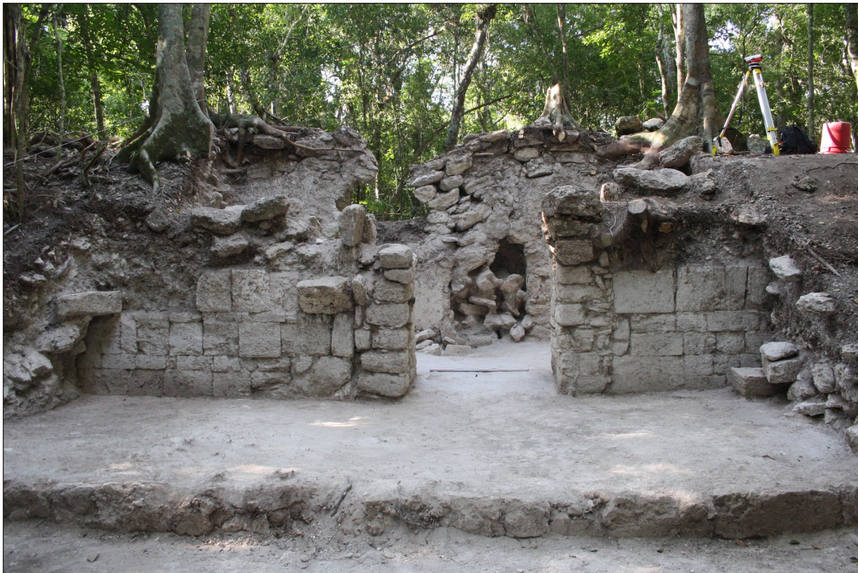
Figura 10. Fachada norte del edificio 6O5 donde se aprecia la reducción de la puerta de acceso (foto Proyecto Naachtun).
