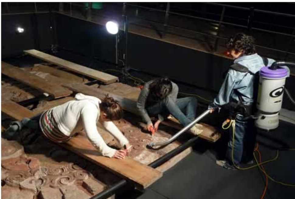
FIGURA 145. Limpieza superficial previa a la realización de pruebas de fijado (MDA).
