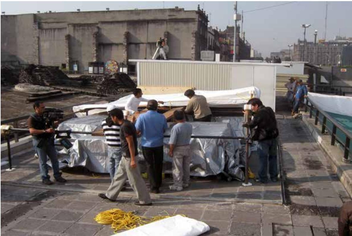
FIGURA 168. Desarmado de estructura tubular de protección (FCM).
