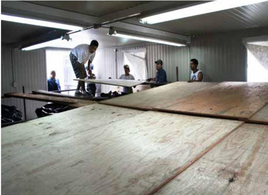
FIGURA 165. Tablones de madera de pino y hojas de triplay sobre la estructura tubular (FCM).
