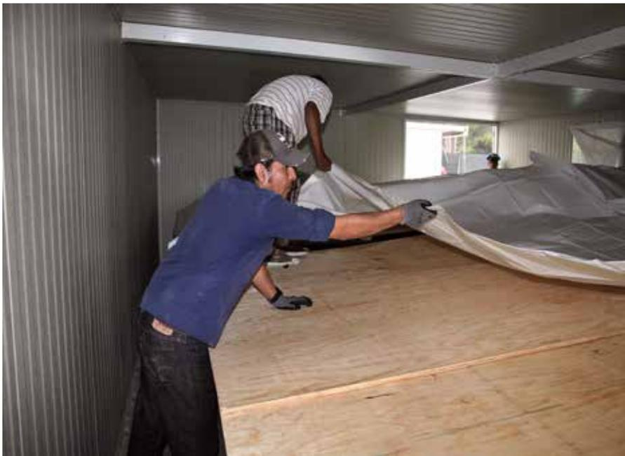
FIGURA 166. Cubierta de todo el sistema con lona plástica (FCM).
