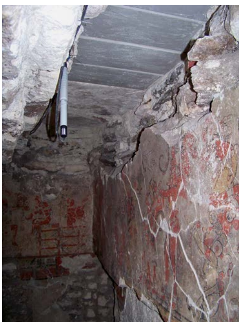
Figura 14. Trabajos de Conservación y Restauración en Cuarto de Pinturas, Sitio San Bartolo ( Fotografía A. Bass 2011)
