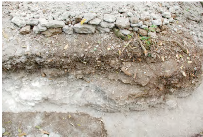
Esquina remetida noroeste, estructura 133. Grupo Saraguaté. (Fotografía R. Arias)
