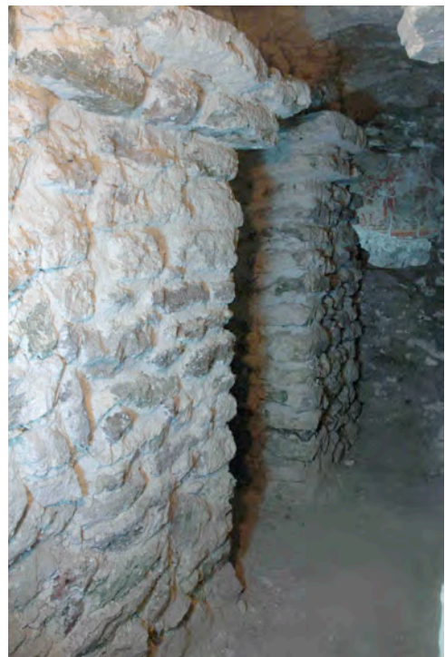
Figura 6. Túnel norte y ventana 4.
