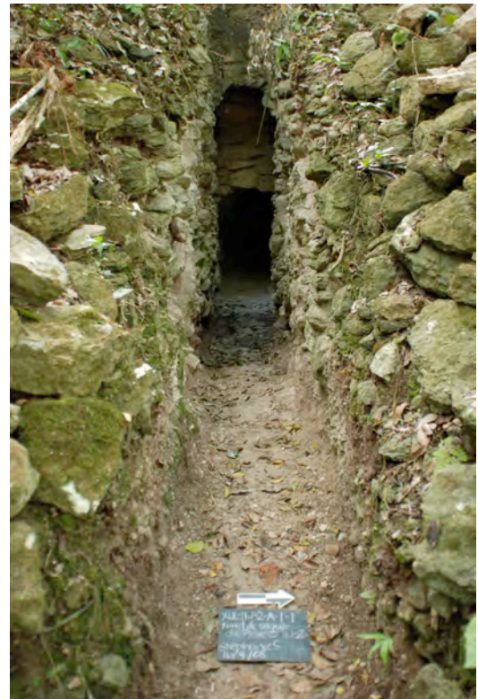
Figura 6. La entrada al túnel de saqueo XUL-11J-2-A-1.
