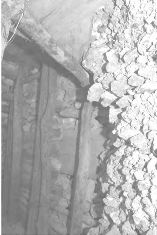
Figura 3: Apuntalamientos y rellenos internos del tunel de saqueo en Las Ventanas.
