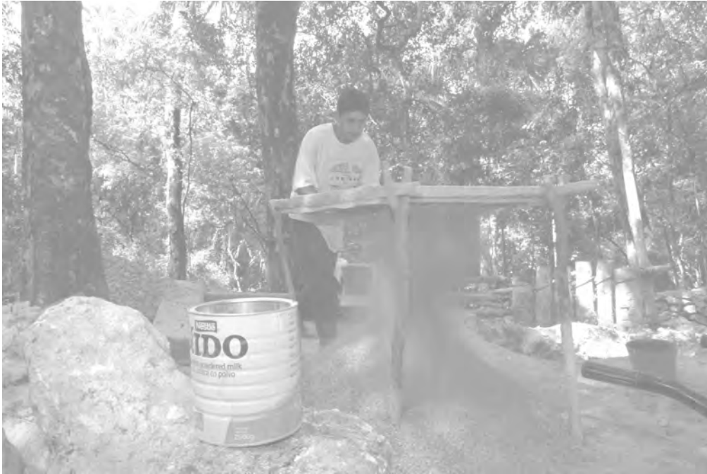
Figura 1: Cernido de tierra para preparar la mezcla de relleno
