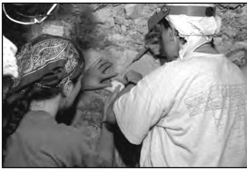
Proceso de inyección de mezcla en las pinturas murales del muro oeste
