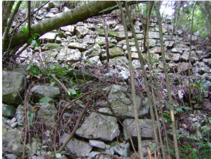
Fig. 24. Muro de contención de la terraza al Oeste. (Foto A. Campiani)
