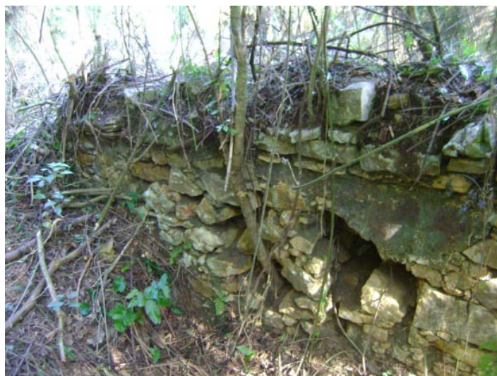
Fig. 22. Bóveda de la estructura I-25. (Foto A. Campiani)
